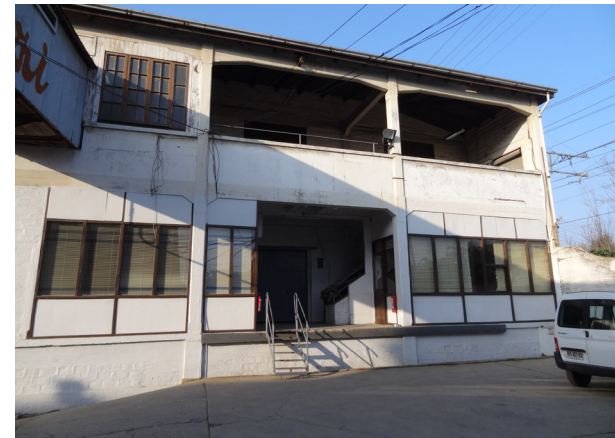
Imagen 38, 39 y 40: Fachadas Edificio 2. Fuente: Archivo autora.
