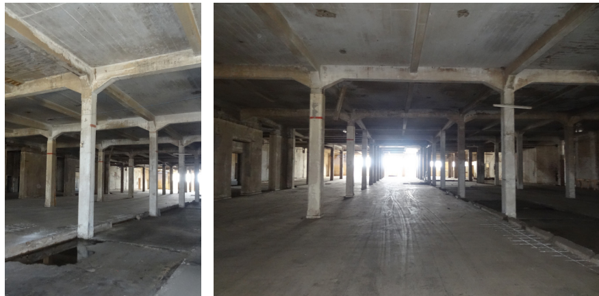
Imagen 65, 66: Levantamiento fotográfico Edificio I. Fuente: Archivo autora.
