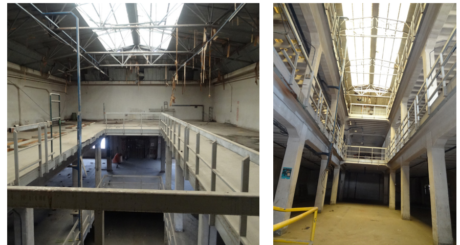
Imagen 71, 72: Levantamiento fotográfico Edificio I. Fuente: Archivo autora.
