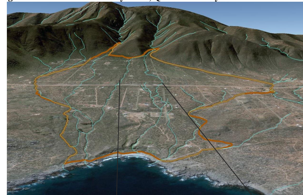
Fig. 36 Sistema en Conos de deyección, Quebrada Arrayán
