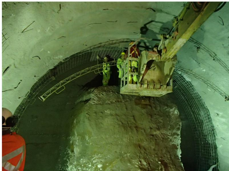
Figura 19: Colocación de marcos reticulados
