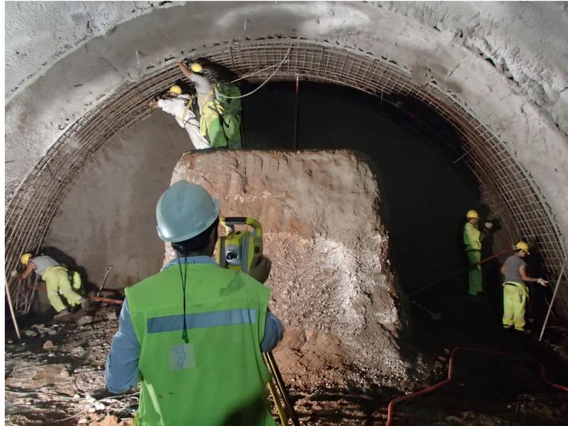
Figura 20: Chequeo topográfico de marcos reticulados
