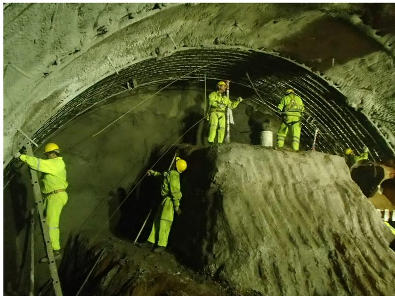
Figura 21: Colocación de enfierradura
