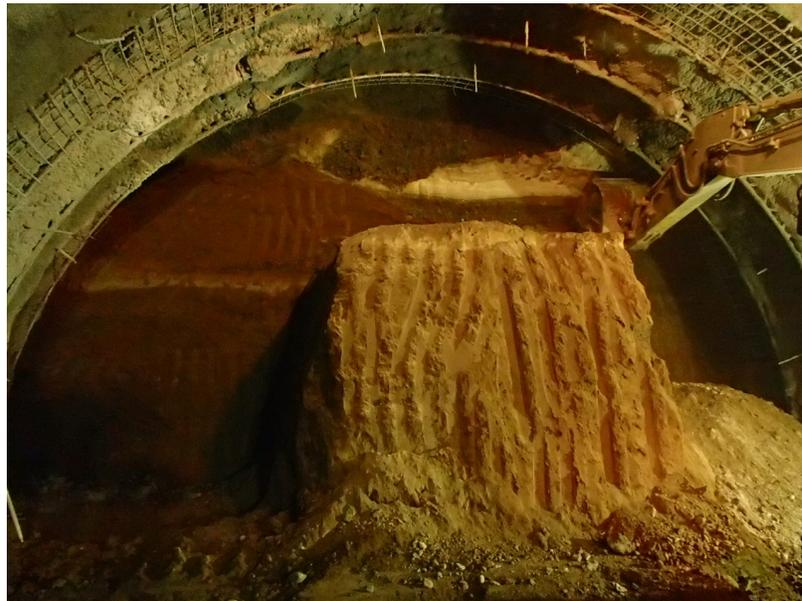
Figura 15: Excavación y retiro de marina
