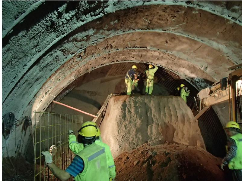
Figura 18: Colocación de mallas electrosoldadas
