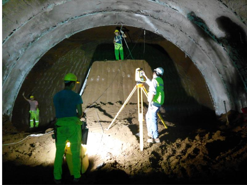
Figura 16: Chequeo topográfico de la excavación
