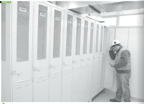
El alto pasadizo facilita en cualquier momento al usuario de la fábrica y al personal de operación el acceso de calidad
