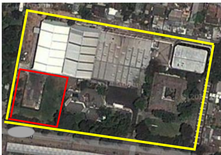
Ilustración 17: Imagen satelital del lugar dónde se instalará la planta.
