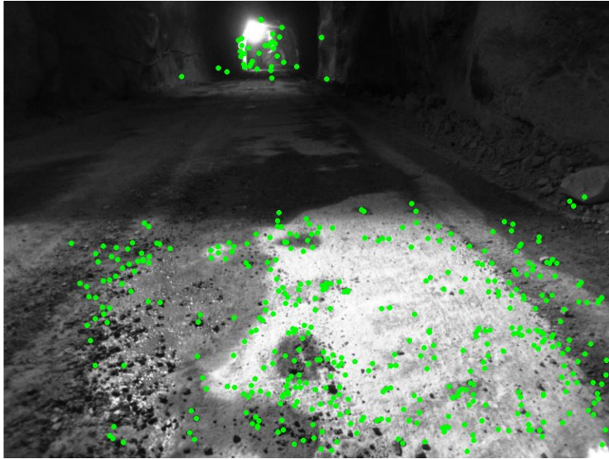
Ilustración 23: Características detectadas en el tramo oscuro del túnel.
