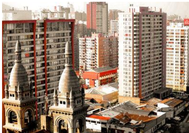
Fig. 16 Se observa la Parroquia del Santísimo Sacramento, rodeada de edificios que han debilitado su presencia como hito urbano. En http://www.construhub.cl/
