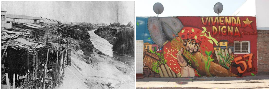
Fig. 12 Callampas en el Zanjón de la Aguada. Fuente: Revista VEA, 14.04.1952, en: http://mingaonline.uach.cl/
