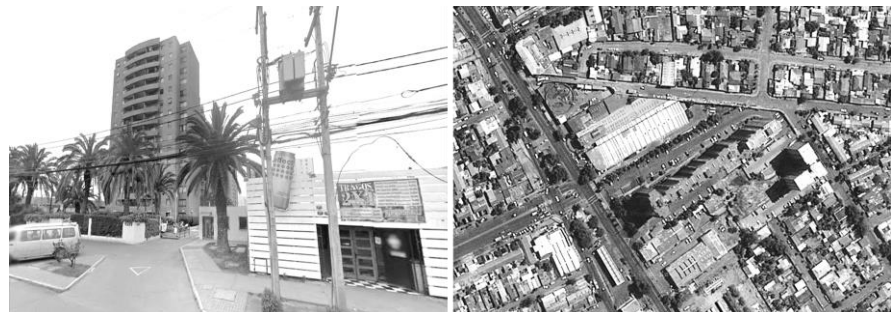
Fig. 22 Una de las edificaciones más altas de la comuna de Conchalí, el acceso se localiza en independencia, pero hacia las calles interiores está aislado, al igual que el galpón industrial que antes existía. Fuente: Google Street View y Google Earth.
