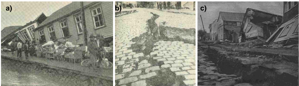
Fig. 3-8 Daños y grietas. (Fuente: Revista Vea – 26 mayo de 1960).
