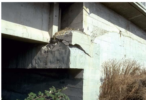
Fig. 4-44 Daños puente Lo Gallardo terremoto 1985 (James H. Gates).
