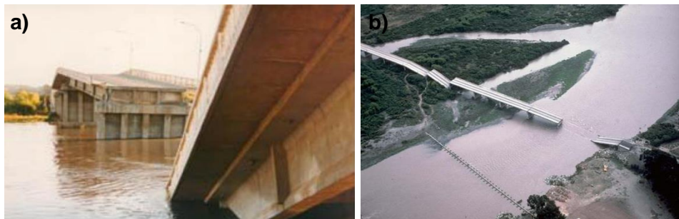
Fig. 3-39 Puente Lo Gallardo 1985 (a) M. Astroza y b) James H. Gates).
