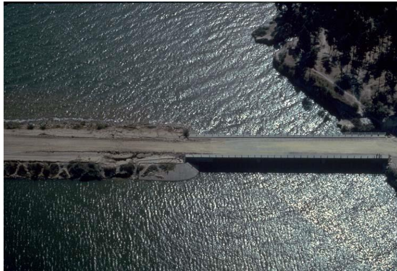
Fig. 4-54 Asentamiento de relleno en 1985 (James H. Gates).
