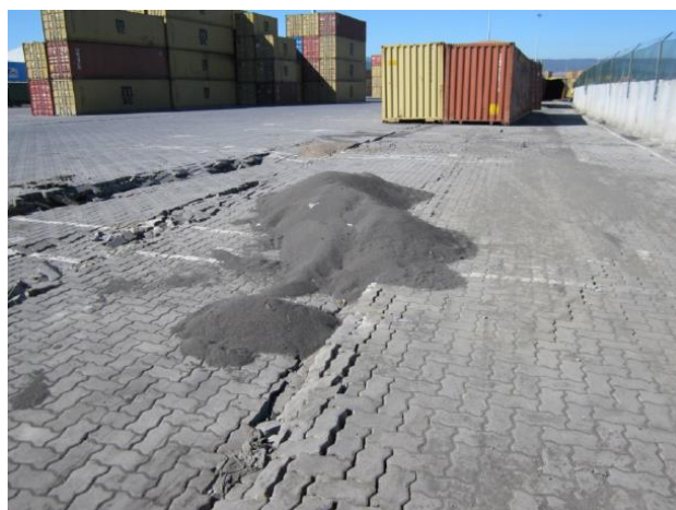
Fig. 6-44 Arena eyectada en Puerto de Coronel (GEER, 2010).
