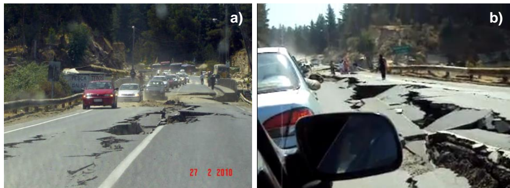
Fig. 4-55 Grietas en Puente (a) MOP y b) usuario CVC334 en youtube).
