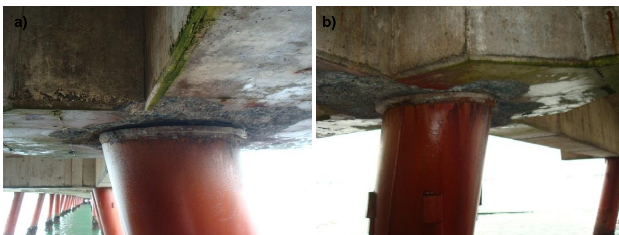
Fig. 6-50 a) Desprendimiento de material en unión de pilote y losa y b) detalle de estructura del pilote (Puerto de Coronel, 2012).
