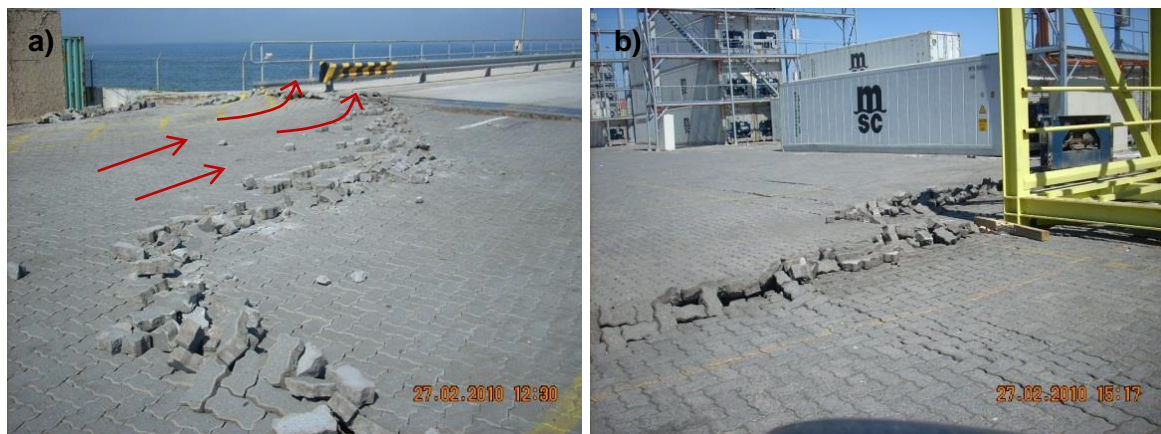
Fig. 6-47 Grietas perpendiculares a) sector acceso Muelle Sur y b) sector acceso Muelle Norte (Puerto de Coronel, 2012).
