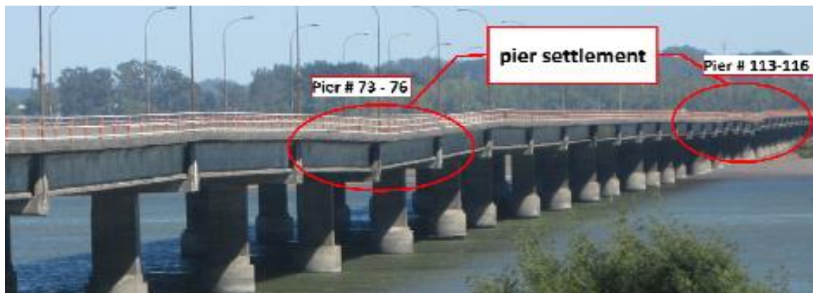
Fig. 4-63 Asentamiento de las pilas en Puente Juan Pablo II (GEER, 2010).
