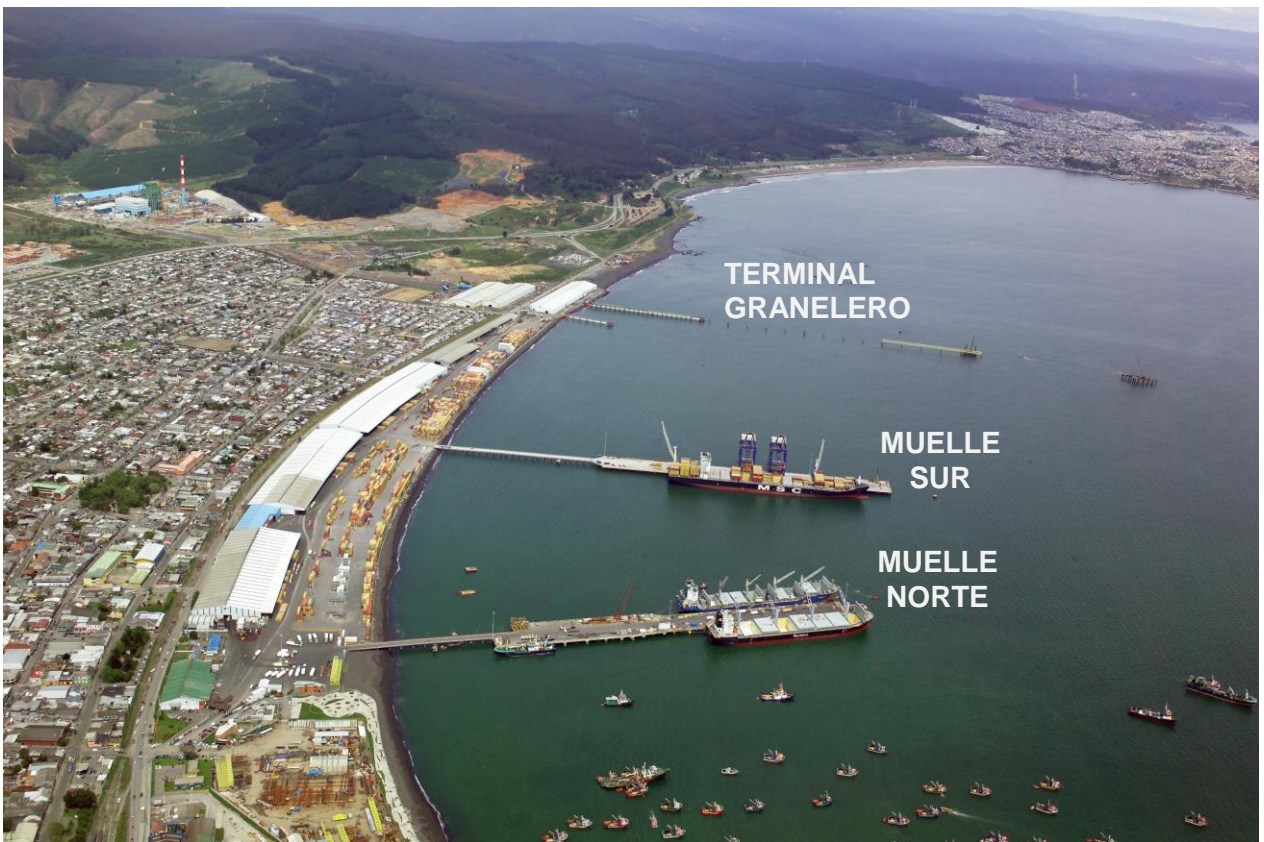
Fig. 6-2 Vista aérea de los muelles del Puerto de Coronel (Puerto de Coronel, 2012).
