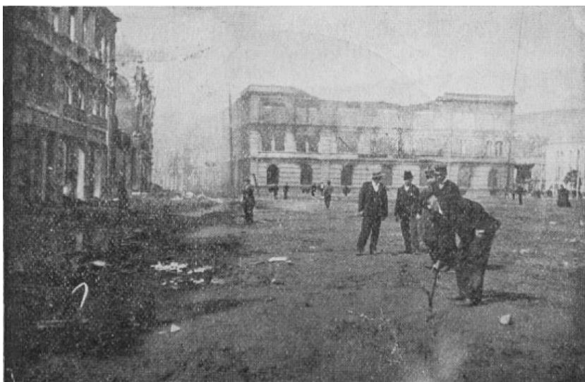
Fig. 3-2 Hombre midiendo la profundidad de una grieta (Rodríguez y Gajardo, 1906).
