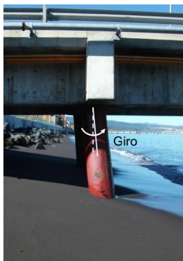
Fig. 6-51 Giro en pilote del Muelle Sur (Brunet, 2012).
