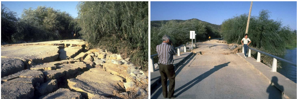
Fig. 4-58 Grietas en río Tinguiririca (James H. Gates).
