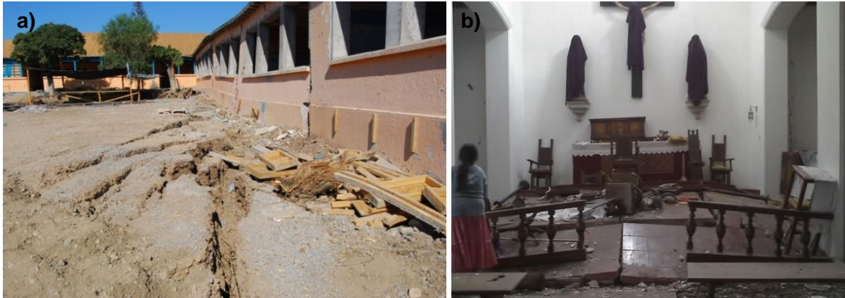
Fig. 4-23 Daños en Escuela de Champa e Iglesia de Abrantes (a) flickr/Paulina Orellana Quinteros y b) fotografía conseguida con vecinos).
