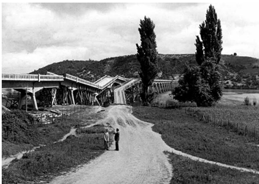
Fig. 3-3 Puente Ñipas Terremoto 1939 (usuario Felipe Rebolledo en panoramio).
