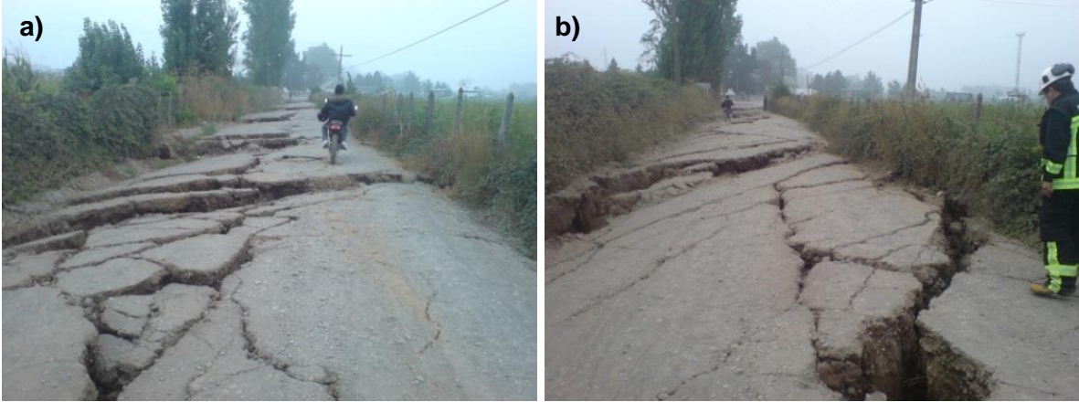
Fig. 5-30 Agrietamiento del camino a Santa Teresa (I. Municipalidad de Retiro).
