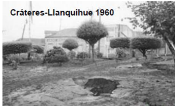
Fig. 3-23 Volcán de arena en Llanquihue (M. Astroza).
