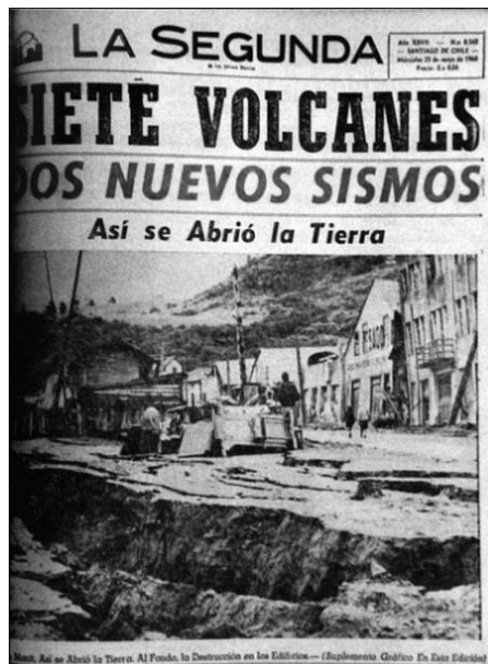
Fig. 3-5 Portada La Segunda, grietas en Puerto Montt (El Mercurio).
