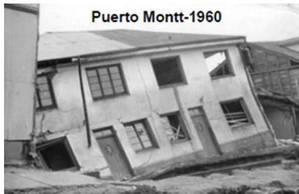
Fig. 3-18 Asentamiento casa en Pto. Montt (presentación M. Astroza).
