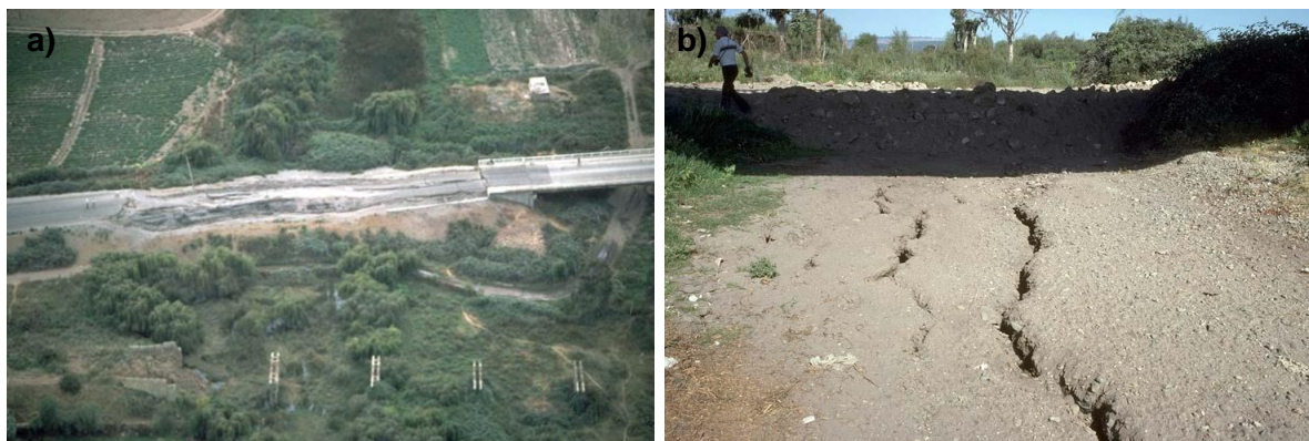
Fig. 4-46 Fallas terraplén y grietas en Puente Lo Gallardo, 1985 (James H. Gates).
