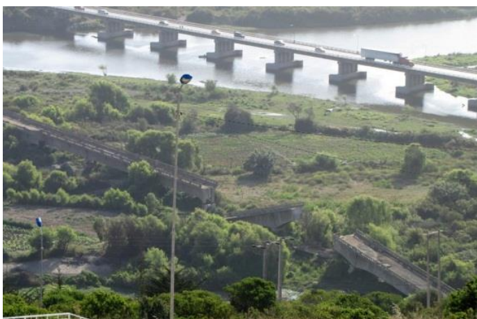
Fig. 4-43 Fotografía general de ambos puentes (MMC/manelo en panoramio).
