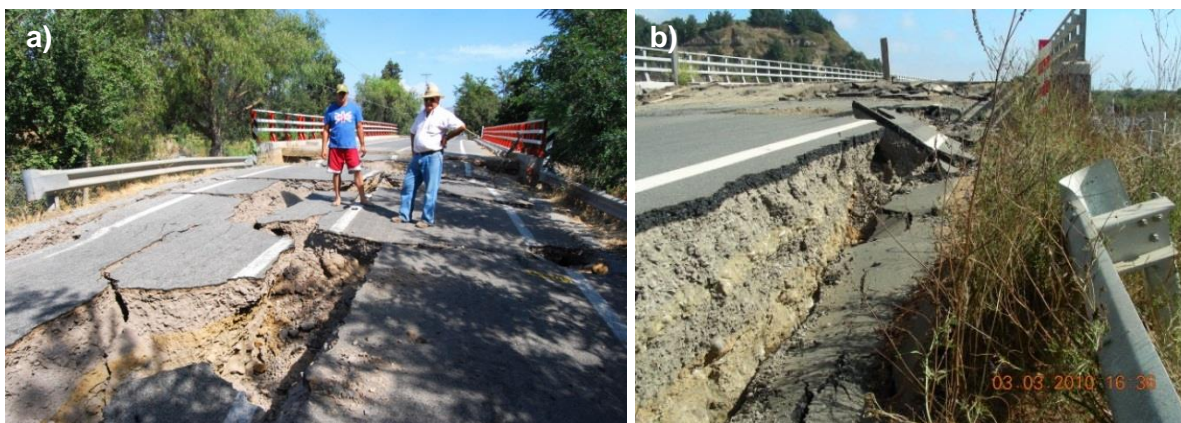
Fig. 4-18 a) Puente Cardonal Bajo (flickr/Paulina Orellana Quineros b) Puente Mataquito (MOP).
