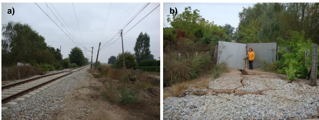
Fig. 5-27 a) Línea de tren y b) grietas en camino de tierra (Sergio Sepúlveda).
