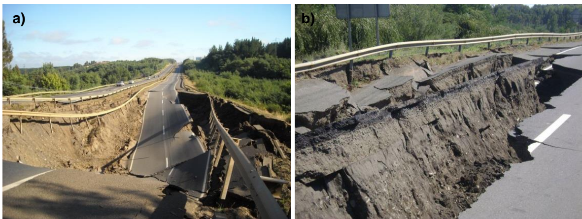
Fig. 4-17 Falla en Mulchén (a) panoramio/ César Fuentealba y b) www2.udec.cl/~frquilodran ).
