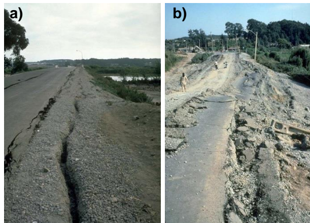
Fig. 3-40 Fallas terraplenes Puente Lo Gallardo, 1985 (James H. Gates).
