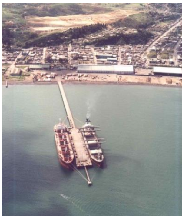
Fig. 6-3 Primera etapa Muelle Norte (Puerto de Coronel, 2012).
