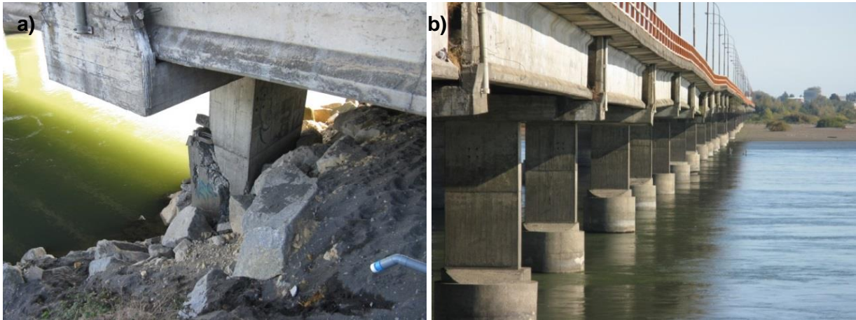
Fig. 4-13 a) Falla en pila y b) asentamientos en cepas Puente Juan Pablo II.
