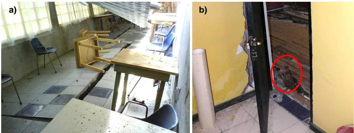
Fig. 5-10 a) Hundimiento de la edificación y b) flotación de tronco (Paula Fuentes).
