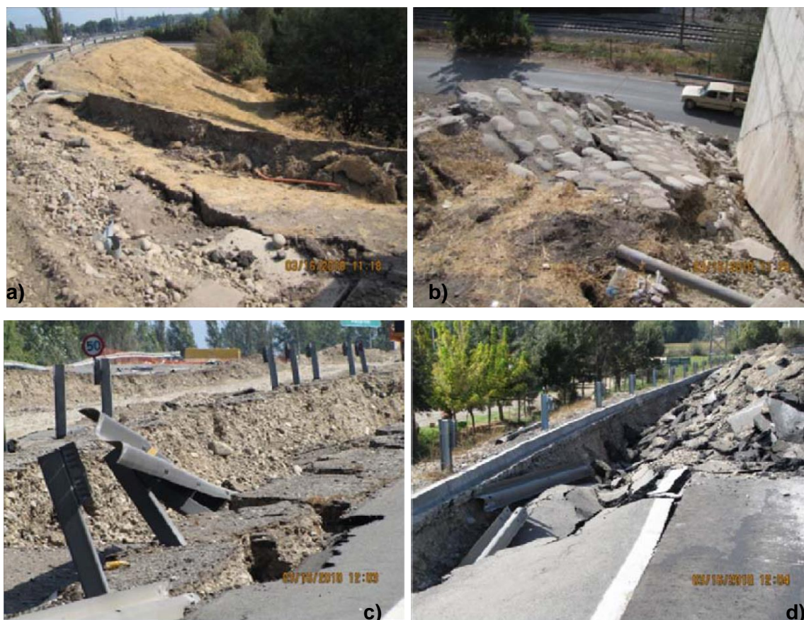
Fig. 4-53 Falla en terraplén, estribo y ruta (GEER, 2010).
