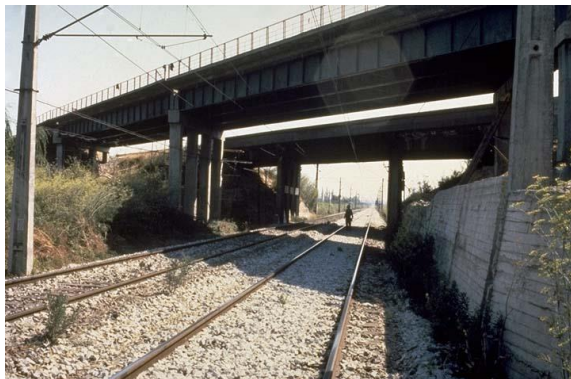
Fig. 3-41 Vista transversal de los puentes del Paso Superior Hospital (James H. Gates).
