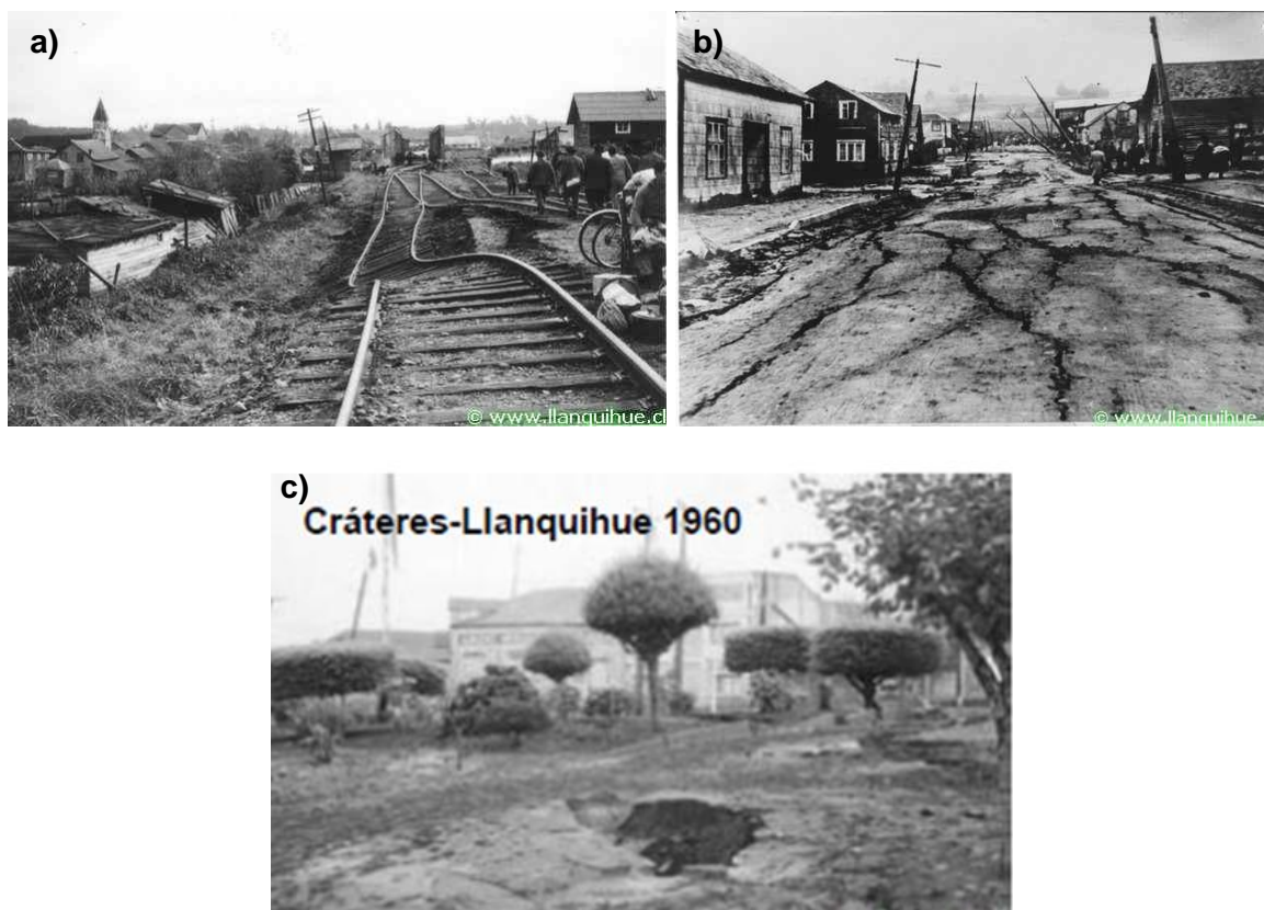
Fig. 4-66 Hundimiento en vía del tren, agrietamiento y volcán de arena en Llanquihue (www.llanquihue.cl y presentación M. Astroza).
