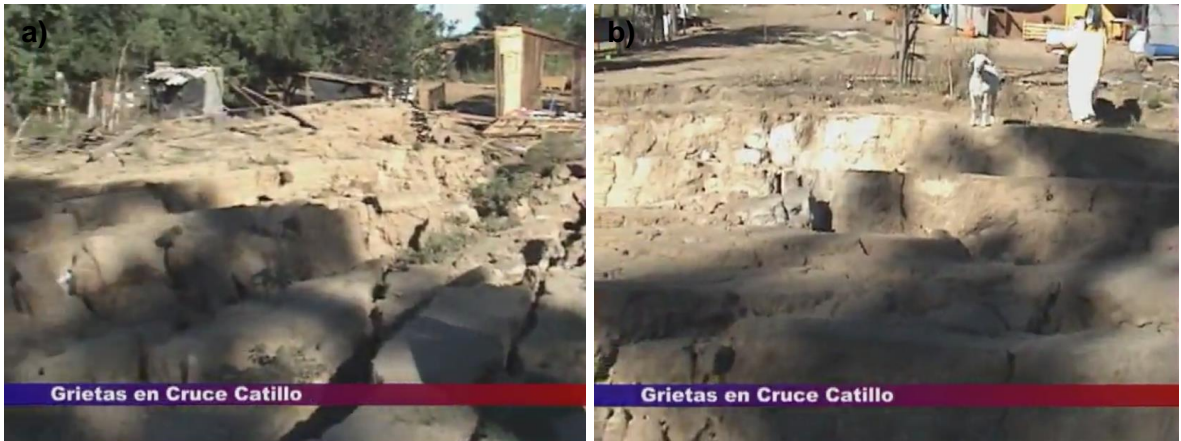
Fig. 5-32 Grietas en cruce a Catillo (usuario ppdaza en youtube).
