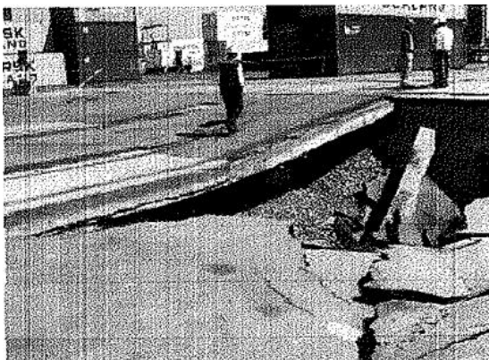
Fig. 4-42 Asentamiento del terreno cerca del Sitio 3, 2010 (www.dgop.cl).
