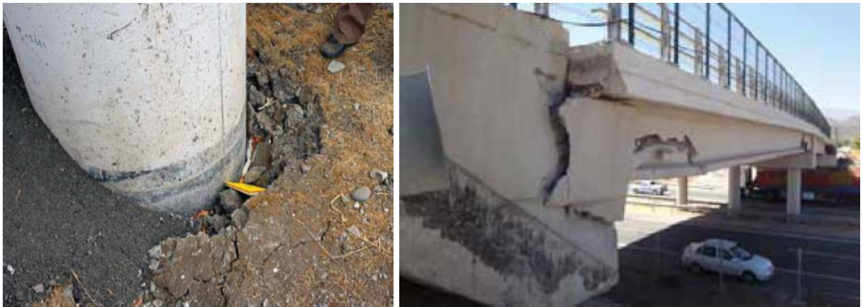
U : Google Earth // D: Separación de columna entre 15 y 20 cm y desplazamiento de la estructura (FHWA, 2011)
