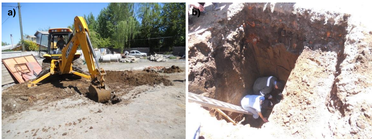
Fig. 5-35 Calicata de extracción de muestras.
