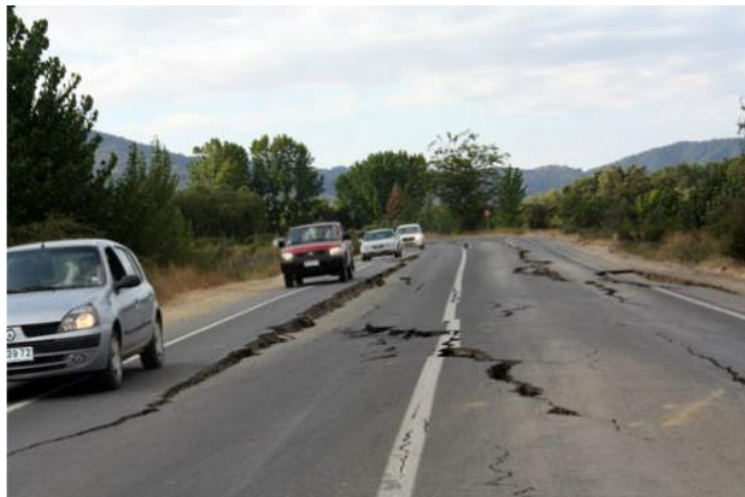
Fig. 4-57 Grietas en camino de acceso al Puente Alhué (MOP).
