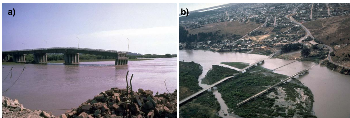
Fig. 4-45 Puente Lo Gallardo 1985 (James H. Gates).
