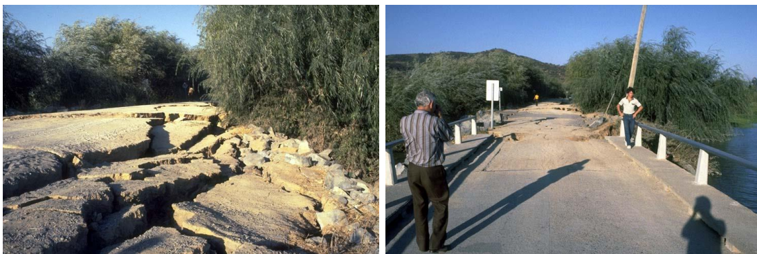
Fig. 3-45 Falla del terreno en las cercanías del río Tinguiririca (James H. Gates).
