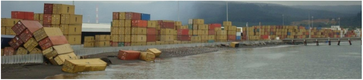
Fig. 6-40 Caída de containers (Puerto de Coronel, 2012).
