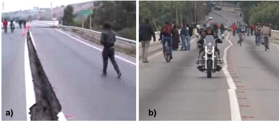
Fig. 4-47 Grieta en acceso sur y desplazamientos laterales Puente Lo Gallardo 2010 (Canal tvsanantoniochile en portal youtube).
