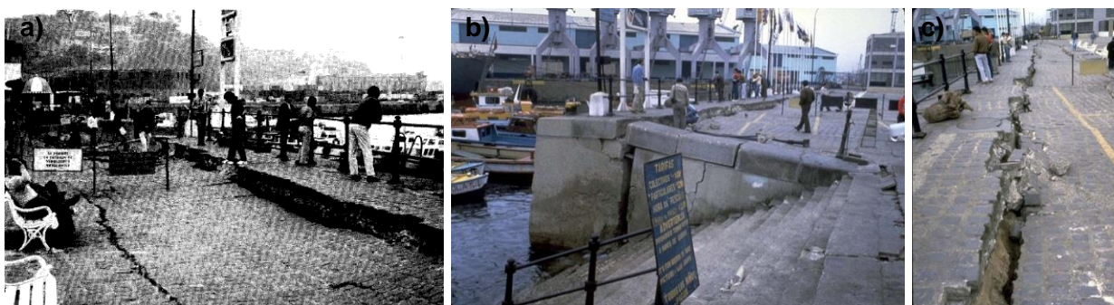
Fig. 4-50 Muelle Prat en 1985 (a) Earthquake Spectra, 1986, b) y c) James H. Gates).
