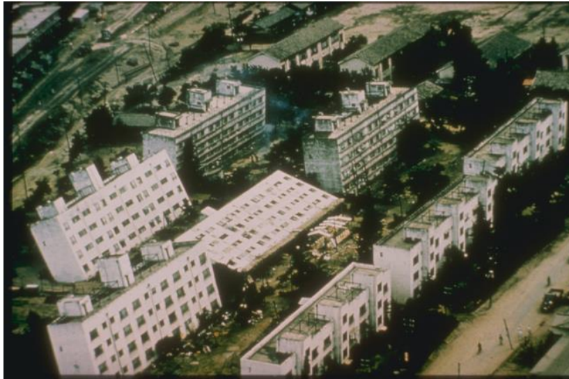
Fig. 2-5 Edificios inclinados Niigata en 1964 (NOAA National Geophysical Data Center).
