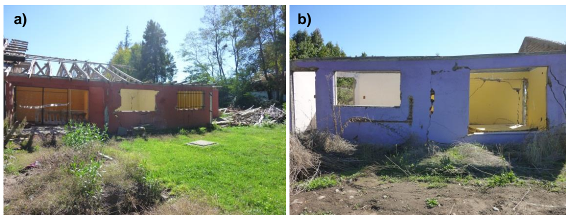
Fig. 4-26 Daños en cuartel de Bomberos y casa en Retiro.
