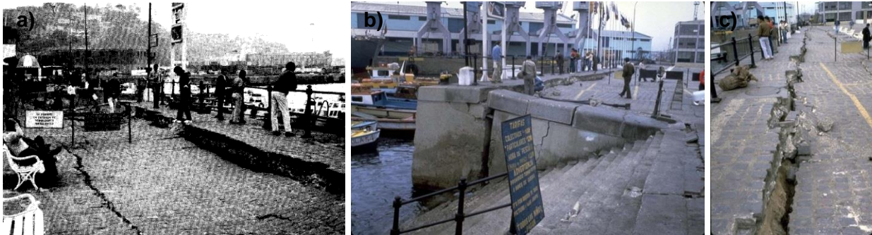
Fig. 3-38 Muelle Prat en 1985 (a) Earthquake Spectra, 1986, b) y c) James H. Gates).
