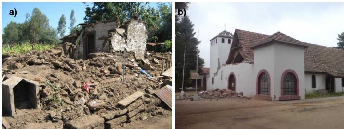
Fig. 5-24 Casa destruida e iglesia dañada (I. Municipalidad de Retiro, 2011).
