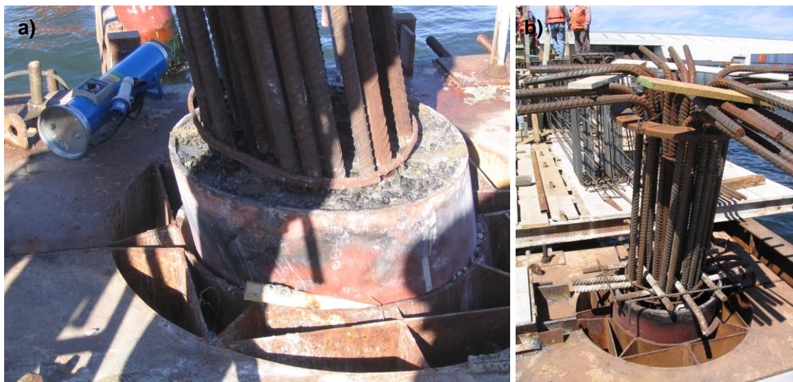
Fig. 6-49 Capitel y Chascas de pilotes (Puerto de Coronel, 2012).
