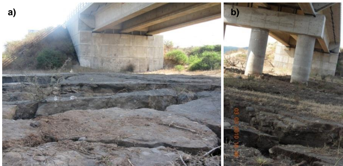
Fig. 4-10 Grietas de lateral spreading en Puente Mataquito.
