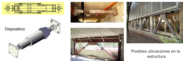
Figura 1.7: Este es un disipador que funciona en base a émbolos y al movimiento de un fluido viscoso 3 , siendo por tanto un ejemplo de un disipador de tipo viscoso.
