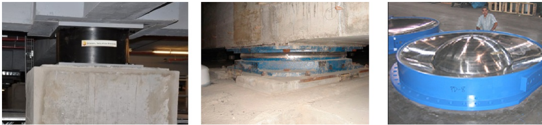
Figura 1.3: Existen diferentes tipos de aisladores; los hay elastoméricos con y sin núcleo de plomo (imagen izquierda), también están los denominados deslizadores (imagen central) y péndulos friccionales (imagen derecha) 2 .
