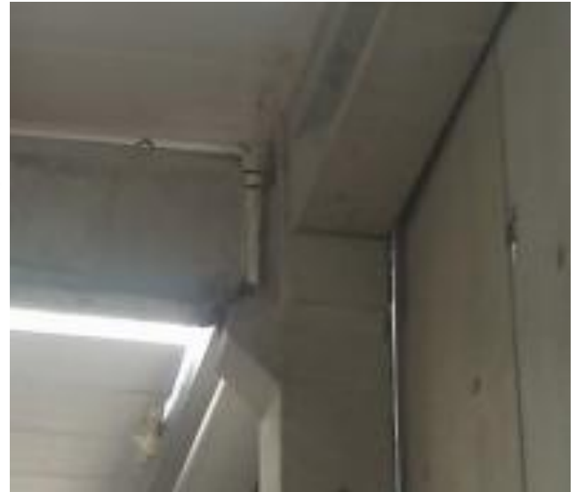
Figura V-18: Fotografía de desplazamiento en conexión húmeda.
