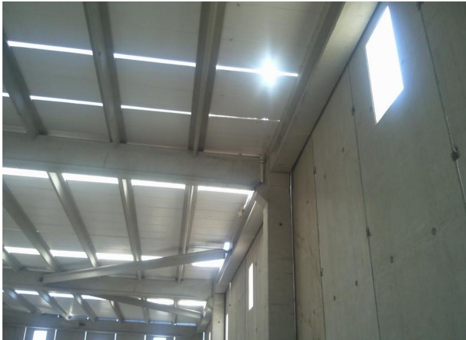
Figura VI-4: Vista interior del galpón, caso 1.
