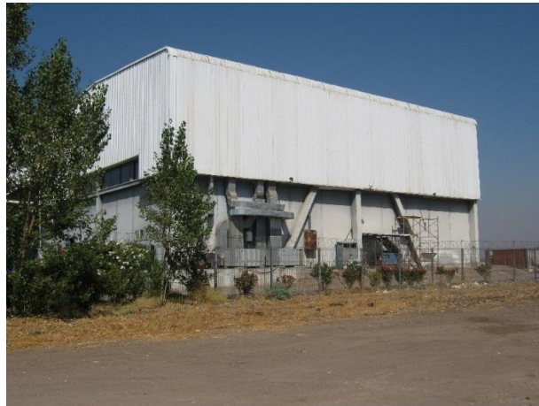
Arriostamientos verticales de hormigón sin daños.
