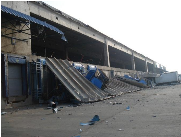
Colapso de paneles verticales de fachada.
