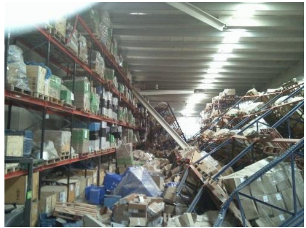
Figura VI-9: Daño severo por derrumbe de arriostramientos de techo de hormigón.
