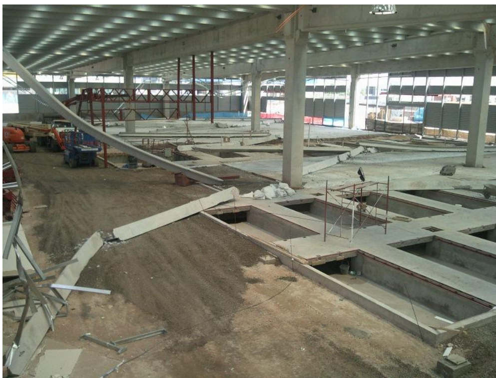
Figura VI-18: Vista interior general de la estructura del caso 2.
