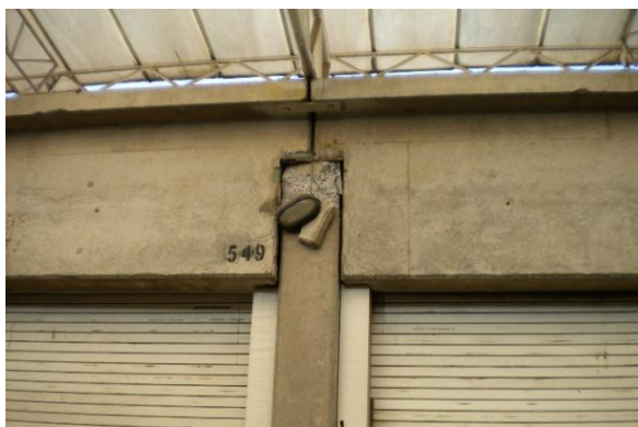
Daños en la conexión pilar – viga
