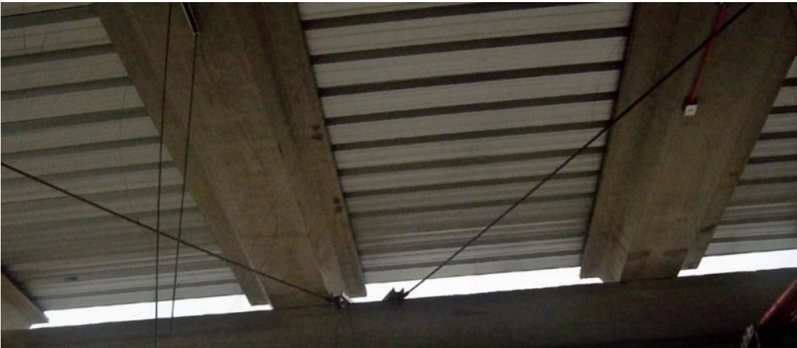
Figura V-32: Arriostramientos de cables en X.
