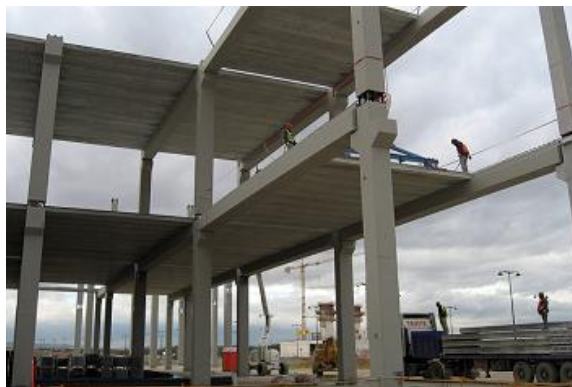
Figura II-1: Ejemplo de construcción con elementos prefabricados.
