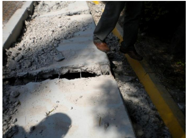
Vigas dintel en el suelo
