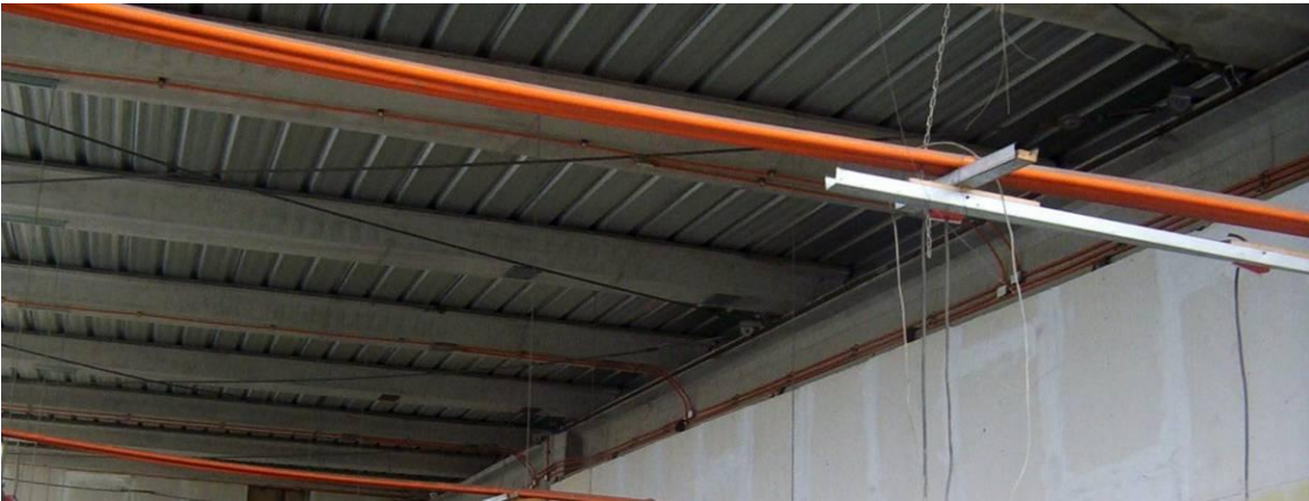
Figura V-31: Arriostramientos de cables en X, vista general.
