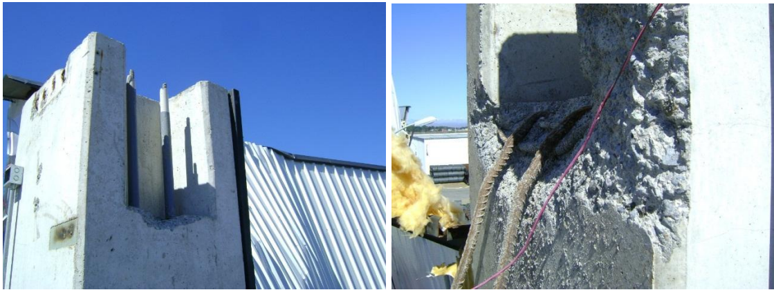
Detalle conexión pilar – columna mediante pasadores.
