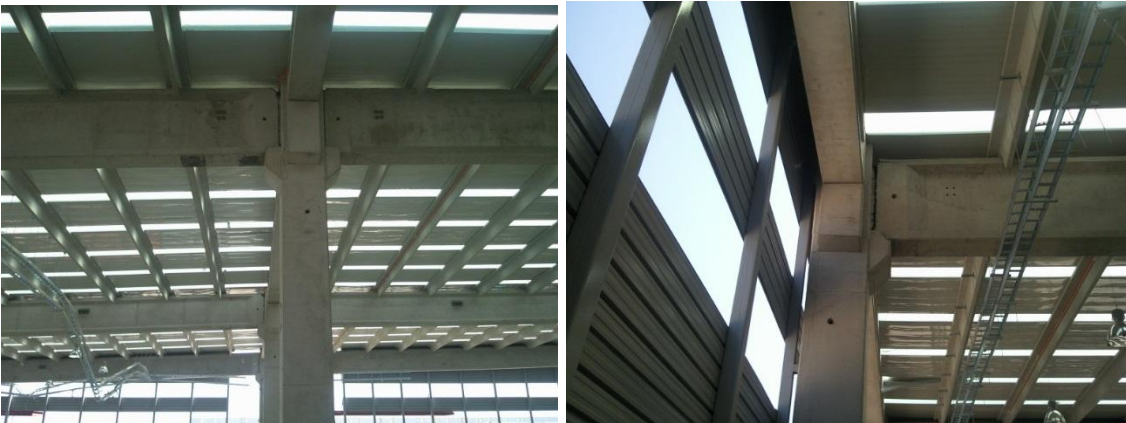
Desplazamiento en consola para conexión pilar – viga.
