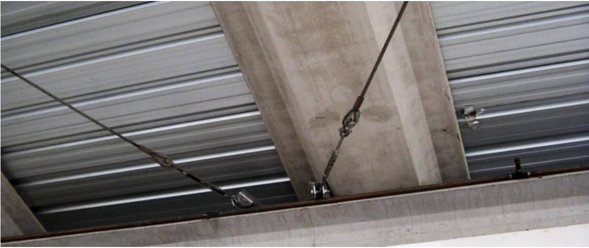
Figura V-33: Conexión de arriostramientos de cables en X.
