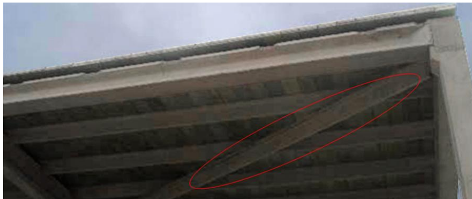
Figura V-25: Arriostramiento de hormigón por viga puntal.
