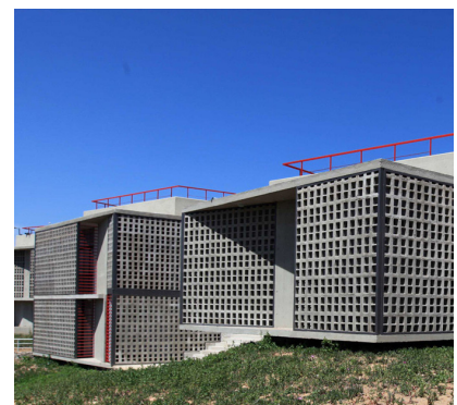
Sede Social Comunitaria / 3 Arquitectos
