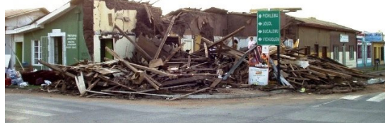
Fotografía posterior a terremoto. Calle 5 de Abril.
