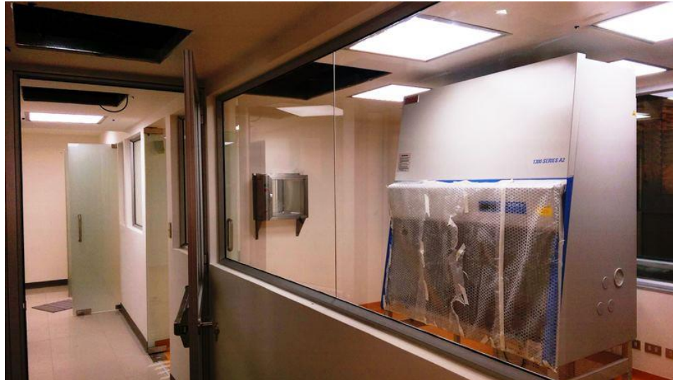
Figura 9. Visualización de la Sala de Purificación y Multiplicación Celular. La foto muestra el gabinete de bioseguridad y la luminaria con Tecnología LED. Faltan los filtros HEPA instalados en el cielo de la sala.
