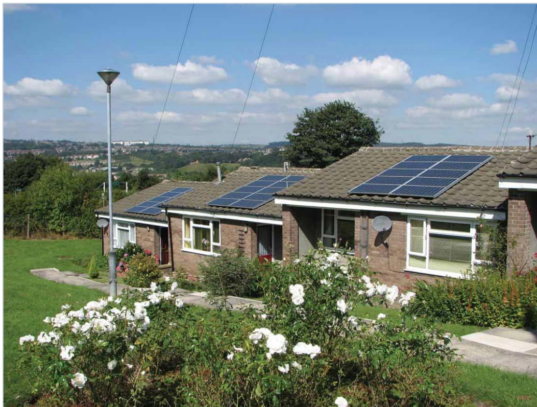
ILUSTRACIÓN 4 INSTALACIÓN FOTOVOLTAICA RESIDENCIAL
