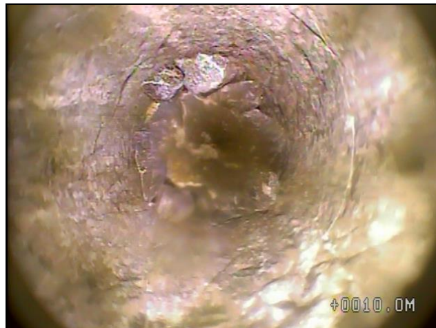
Ilustración 53. Seguimiento auscultación perforación de levante centro, C12 (Superintendencia Mina Norte (c) 2014).
