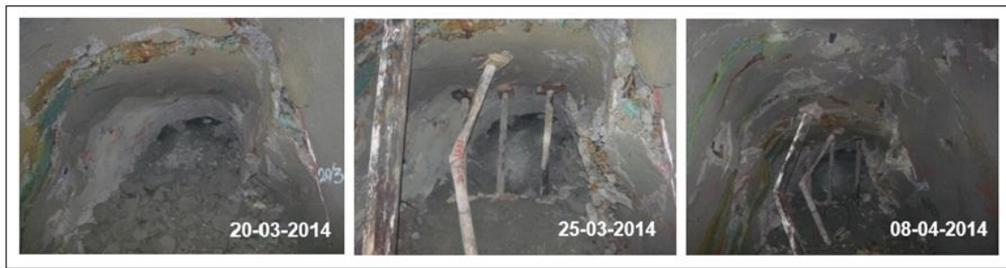
Ilustración 42. Evolución de los daños geomecánicos en C10 UCL (Superintendencia Mina Norte (b) 2014).
