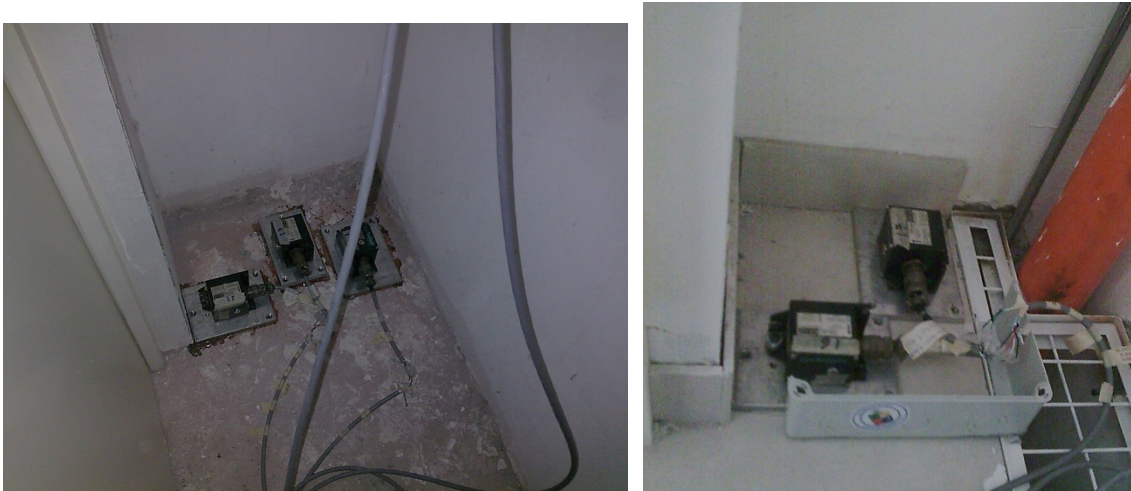
Figura 3.7. Imágenes de acelerómetros en piso -3 (izquierda) y 26 (derecha). (Fuente: Reporte de Instrumentación Velamar Rev. 3-7-2014, Departamento de Ingeniería Civil, Universidad de Chile)
