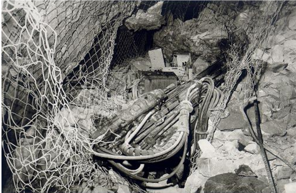
Ilustración 14: Sección de Nivel de Producción afectado por estallido de roca [17]
