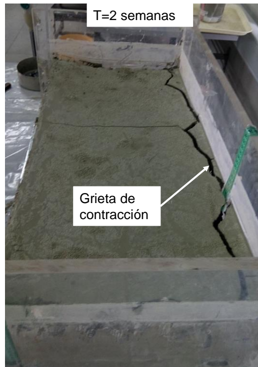
Figura 3.10. Grietas de contracción en las muestras.
