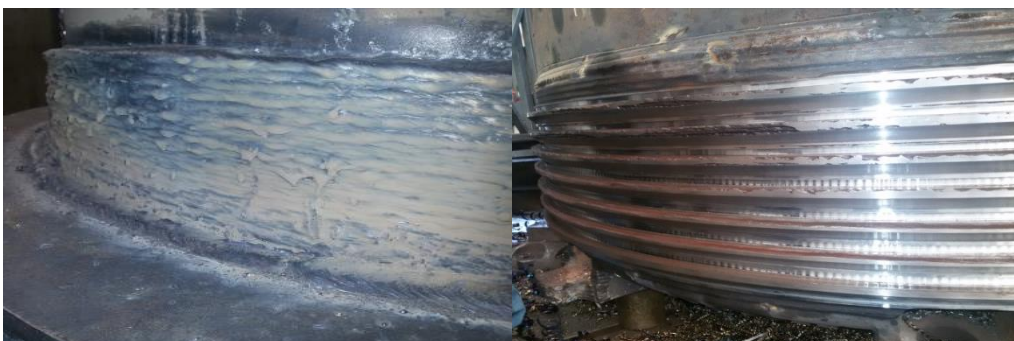
Figura 14: Anillo con aporte de soldadura (izquierda) y luego mecanizado
