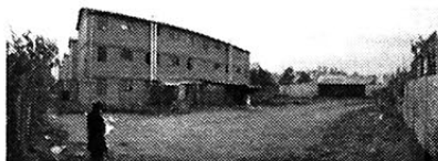
Deterioro de entornos a la vivienda social. Desvalorización del patrimonio colectivo. Fuente: Archivo INVI
