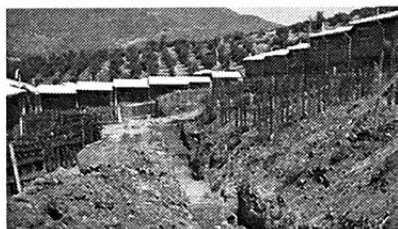
Población Cardenal Silva Henríquez de Curacavi. Ejecución de obras de saneamiento para evitar derrumbes por efecto de la acción de las aguas lluvia. Fuente: Liliana Martínez
