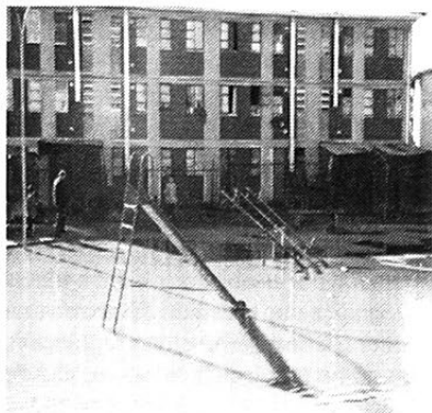
Localización inadecuada de las viviendas sociales.
