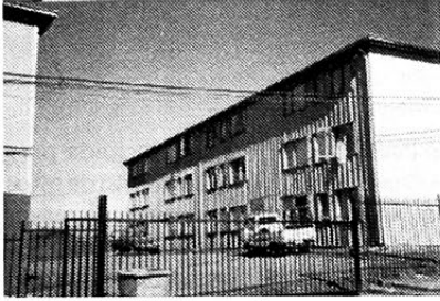
Villa los Cóndores, comuna de Temuco en a demolerse por su mala calidad constructiva. Fuente: Rubén Sepúlveda
