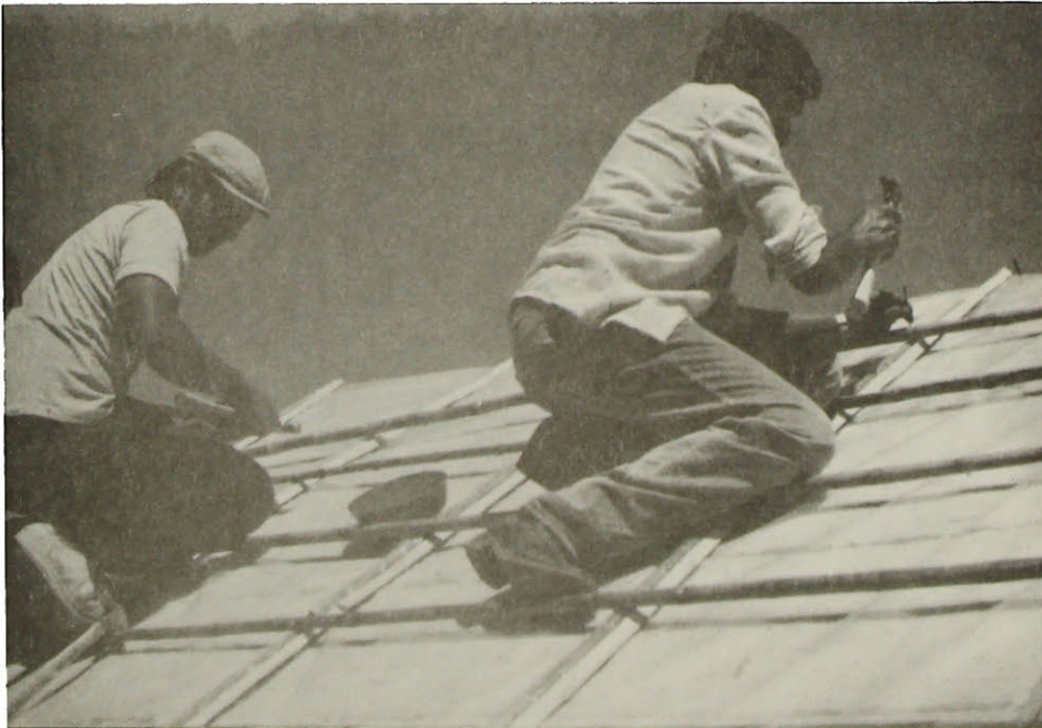
y finalmente la techumbre, la cual también lleva barro y bastante paja para que esta capa sea más liviana
