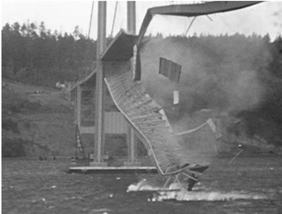
Figura 2.9: Colapso del puente de Tacoma Narrows en 1940, en una imagen de una película filmada por Barney Elliott en una cámara 16 [mm] kodachrome.
