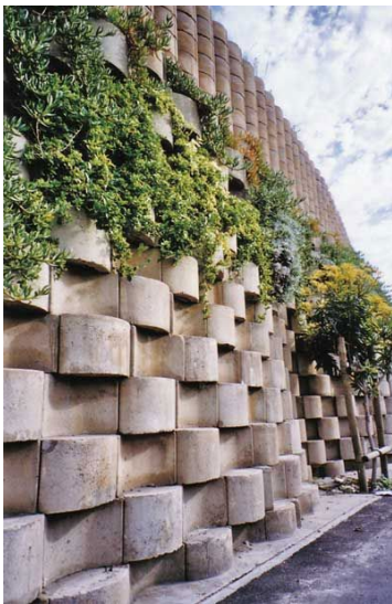
Barrera de sonido en la carretera Stanhope, Cape Town, Sudafrica
