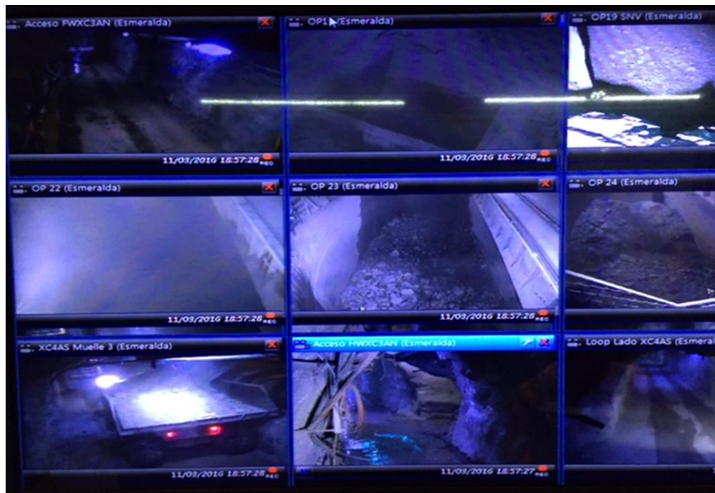
Figura 8-19: Sistema CCTV (camiones & FFCC) Proceso Acarreo Esmeralda
