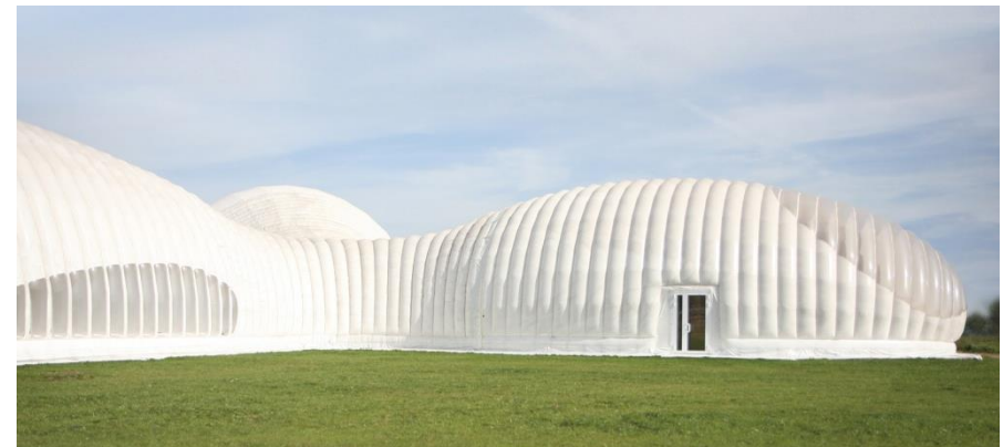
Imagen: trabajo de envoltente para aportar iluminación al espacio interior.
