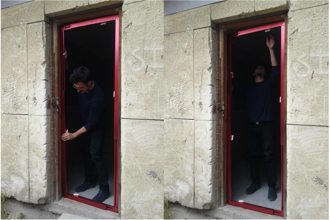
Figura 20. Instalación marco del ventilador.
