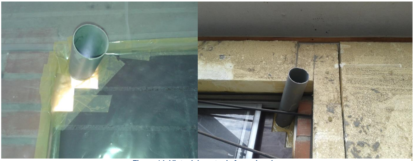
Figura 14. Vista del punto de fuga singular.
