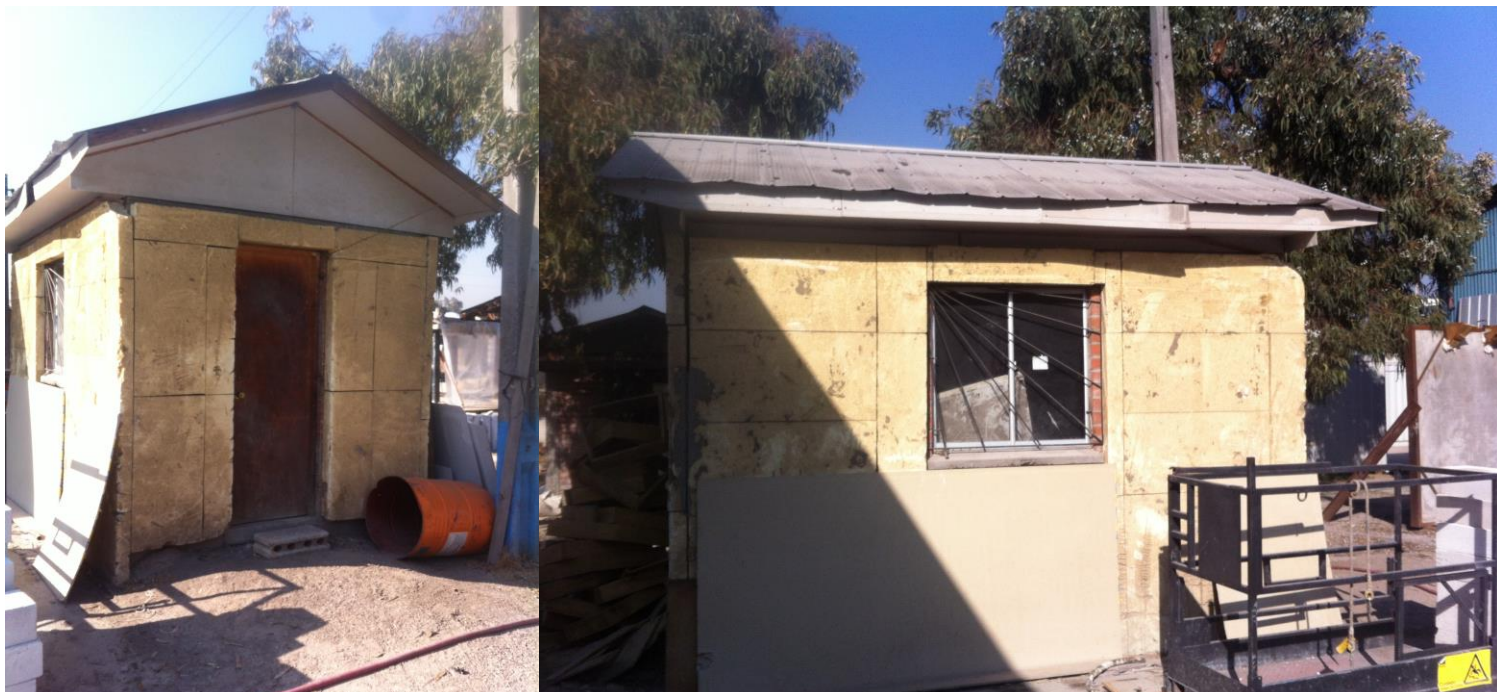
Figura 10. Vista frontal y lateral de la caseta.
