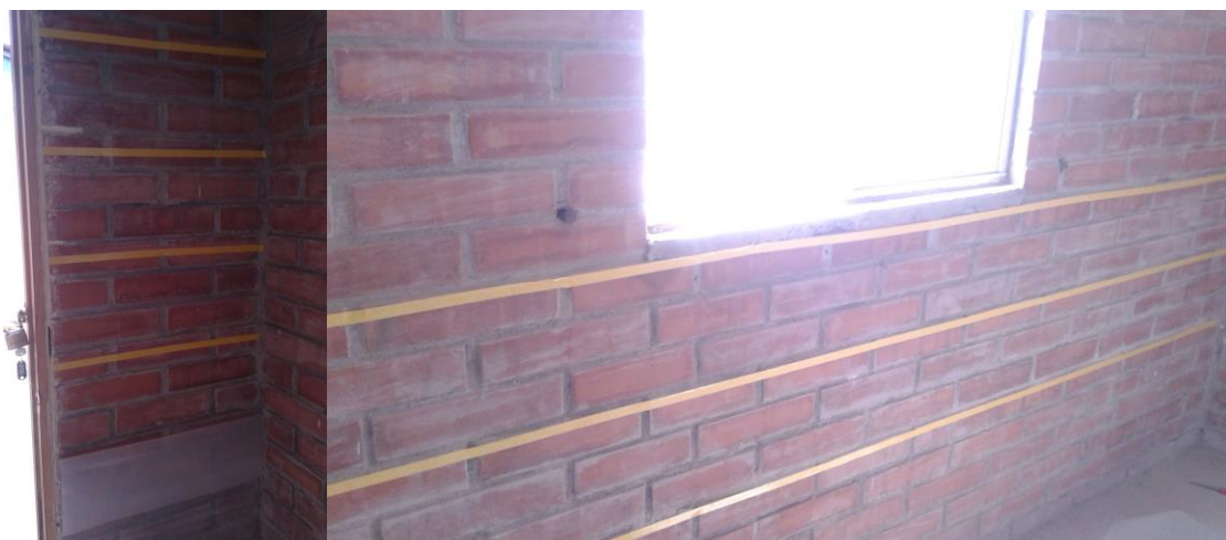
Figura 12. Adhesión de la cinta doble cara en las paredes.
