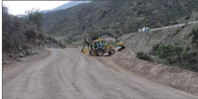
Ilustración 17. Retroexcavadora estandarizando camellón
