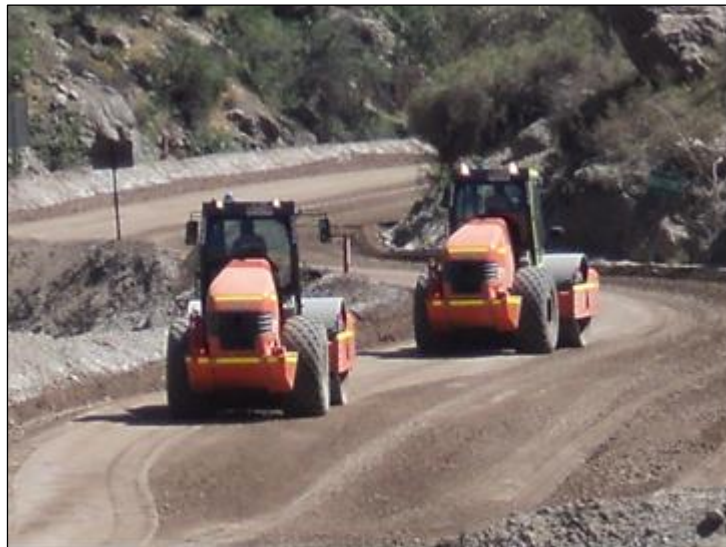
Ilustración 19. Rodillo realizando compactación del camino
