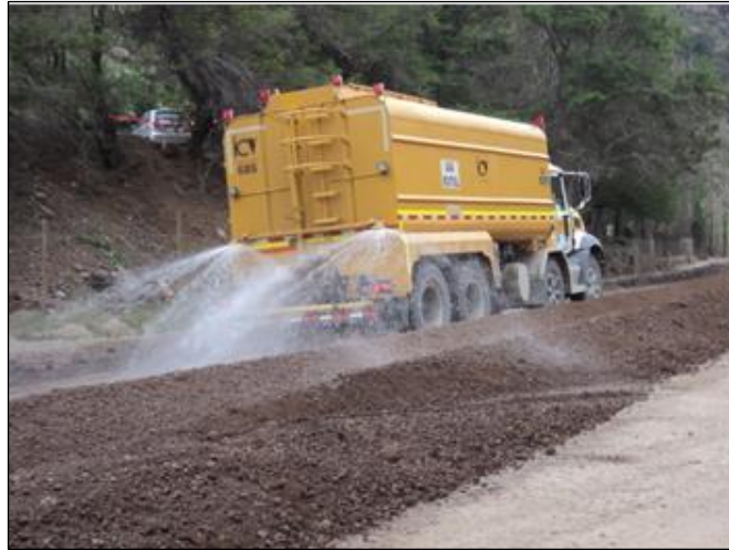
Ilustración 18. Camión Aljibe agregando el agua necesaria
