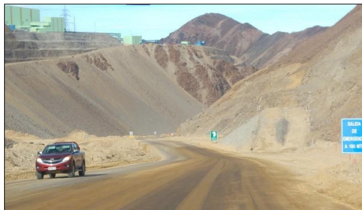
Ilustración 21. Camino industrial de Los Bronces estabilizado con supresor de polvo bituminoso
