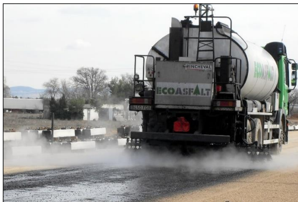
Ilustración 14. Aplicación de emulsiones asfálticas
