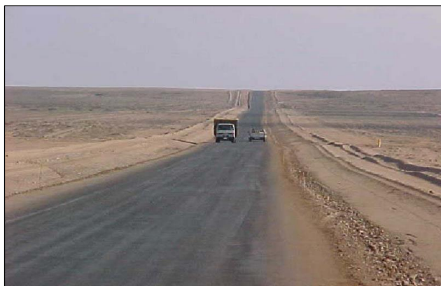
Ilustración 12. Aplicación de cloruro de magnesio
