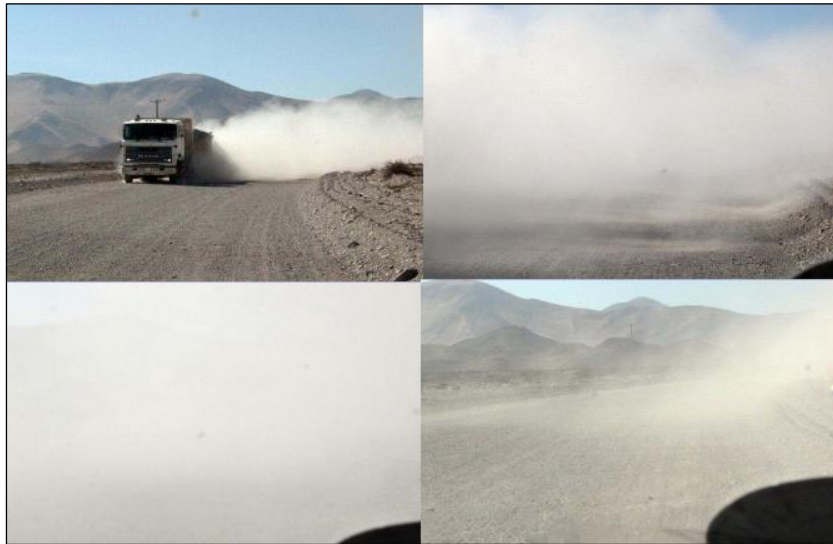
Ilustración 6. Problemas de visibilidad por exceso de polvo en el camino
