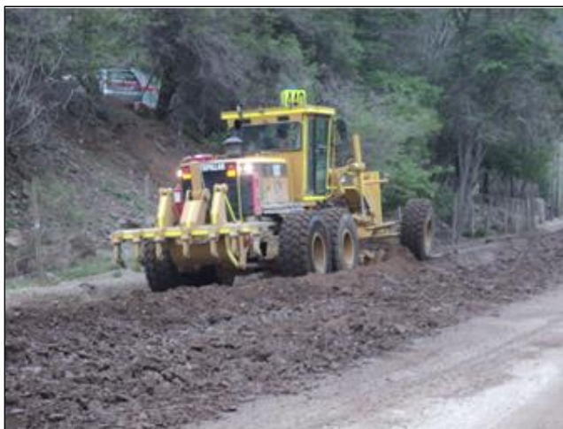
Ilustración 16. Motoniveladora procediendo a escarificar el camino
