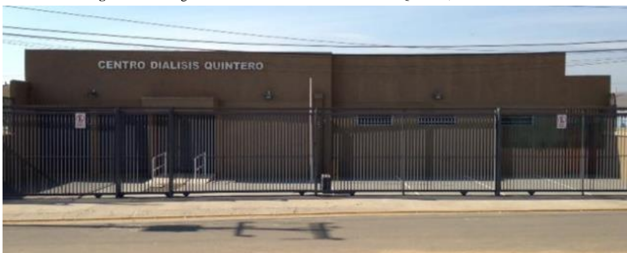
Figura 2-2: Fotografía de la fachada del Centro de Diálisis Quintero, Diciembre 2014.
