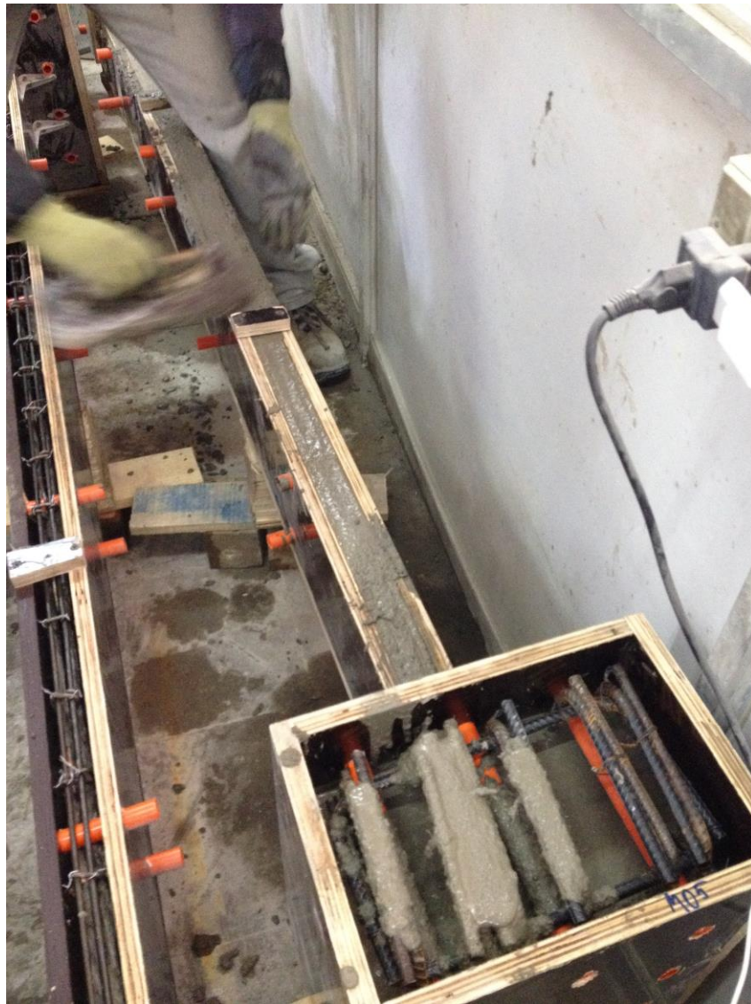
Figura 4-6: Hormigonado de M5
