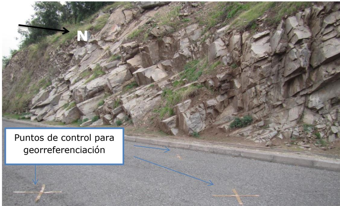
**Figura 25:** La fotografía muestra parte del talud modelado, en ella se señala la posición de los puntos de control para georreferenciación utilizados en el proceso de reconstrucción.
