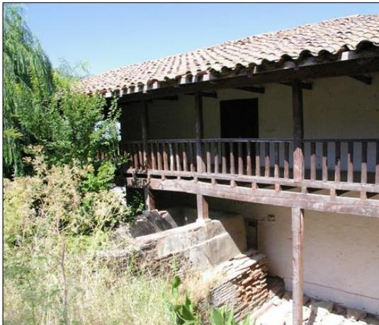
Figura 28: Molino Santa Amelia. Se puede observar la instalación hidráulica la que estaría compuesta por una acequia, conocida como caz, que dirige el agua desde el canal de Almahue hasta el cubo. Fuente: Autora, 2015.
