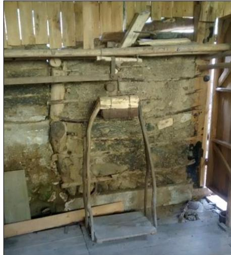
Figura 31: Molino de Pañul en donde se observa un muro testigo de la antigua técnica de “Tabique” además de una pesa artesanal que aun es utilizada por los dueños. Fuente: Autora, 2015.
