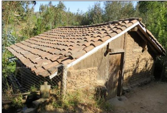
Figura 33: Molino de Rodeillo en donde se observa la techumbre la cual está sostenida por un sistema de cerchas que permite un techo de dos aguas y cumbra de tejas las cuales han sido unidas también por adobe entre ellas. Fuente: Autora, 2015.
