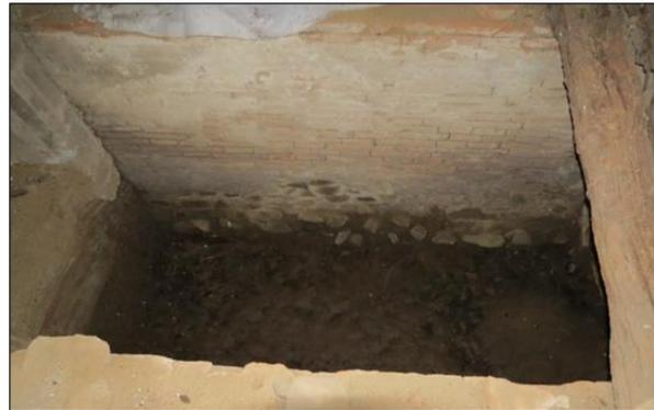
Figura 27: Molino Santa Amelia. Infierno o cámara subterránea en donde se alojó el sistema motriz del molino de agua. Fuente: Autora, 2015.
