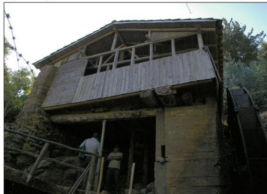
Figura 35: Molino de Rodeillo en donde se observan las paredes de entablado que cubren la mitad del muro, dejando la otra mitad para la ventilación al interior del molino. Fuente: Autora, 2015.
