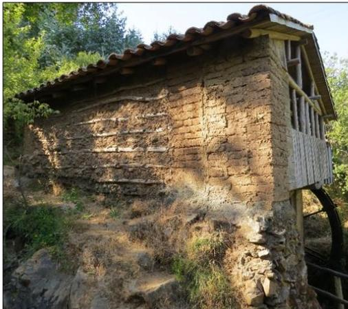
Figura 34: Molino de Rodeillo en donde se observan distintas técnicas de construcción: Adobe, tabiquería y barro con piedras. Fuente: Autora, 2015.
