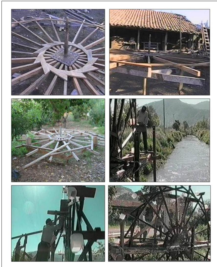
Imagen 15: Proceso de construcción de las Azudas de Larmahue. Fuente: Bravo et al, 2013.
