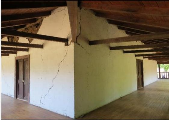
Figura 24: Molino Santa Amelia. Se distinguen los muros de adobe revestidos en cal.
