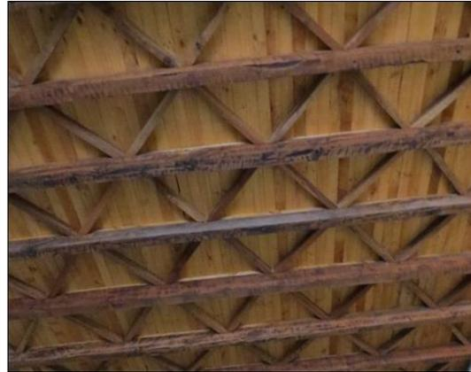
Figura 25: Molino Santa Amelia Cielo del primer nivel sostenido por vigas de roble que están entrelazados por maderos también de roble dispuestos para sostener el peso del segundo nivel en donde se encontraban las bodegas.
