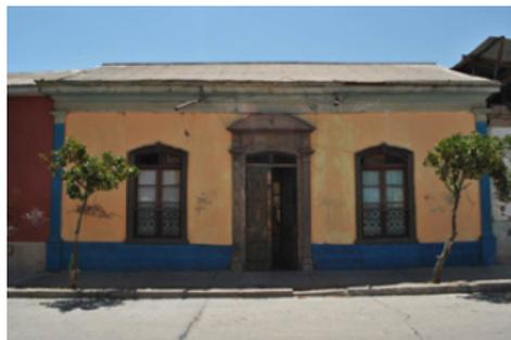
**Cultura Constructiva con Tierra del “Norte Chico”:** Uso de la tierra, la madera y la piedra en el “Norte Chico”, la región de Atacama y Coquimbo. Se utilizan la albañilería de adobe -en viviendas-, la quincha, el ensardinado, y el tabique de madera relleno con adobe -en muros interiores, recintos menores y
