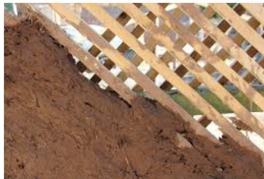
El sistema constructivo propuesto para la vivienda es en quincha con un entramado secundario con palillaje por la cara externa del muro perimetral. La vivienda en sí corresponde a una estructura de madera con pies derechos cada 0.4 m, de sección 2" x 5" en primer piso y 2" x 4" en segundo piso, en pino tratado estructural.
