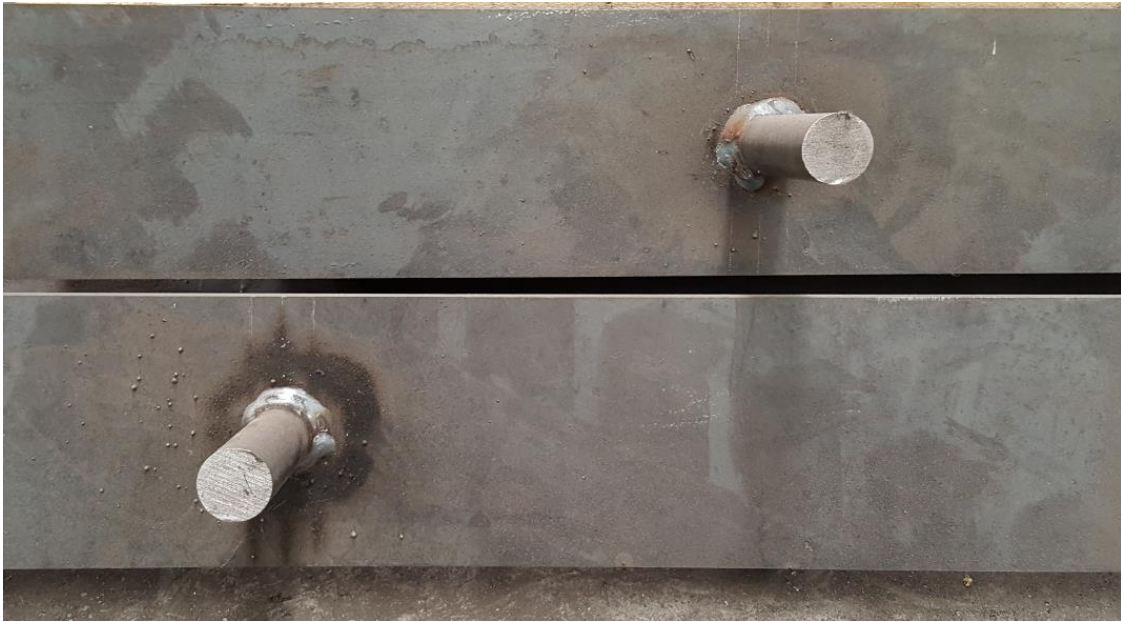
Figura 4.8: Soldadura núcleo de acero y tope central.
