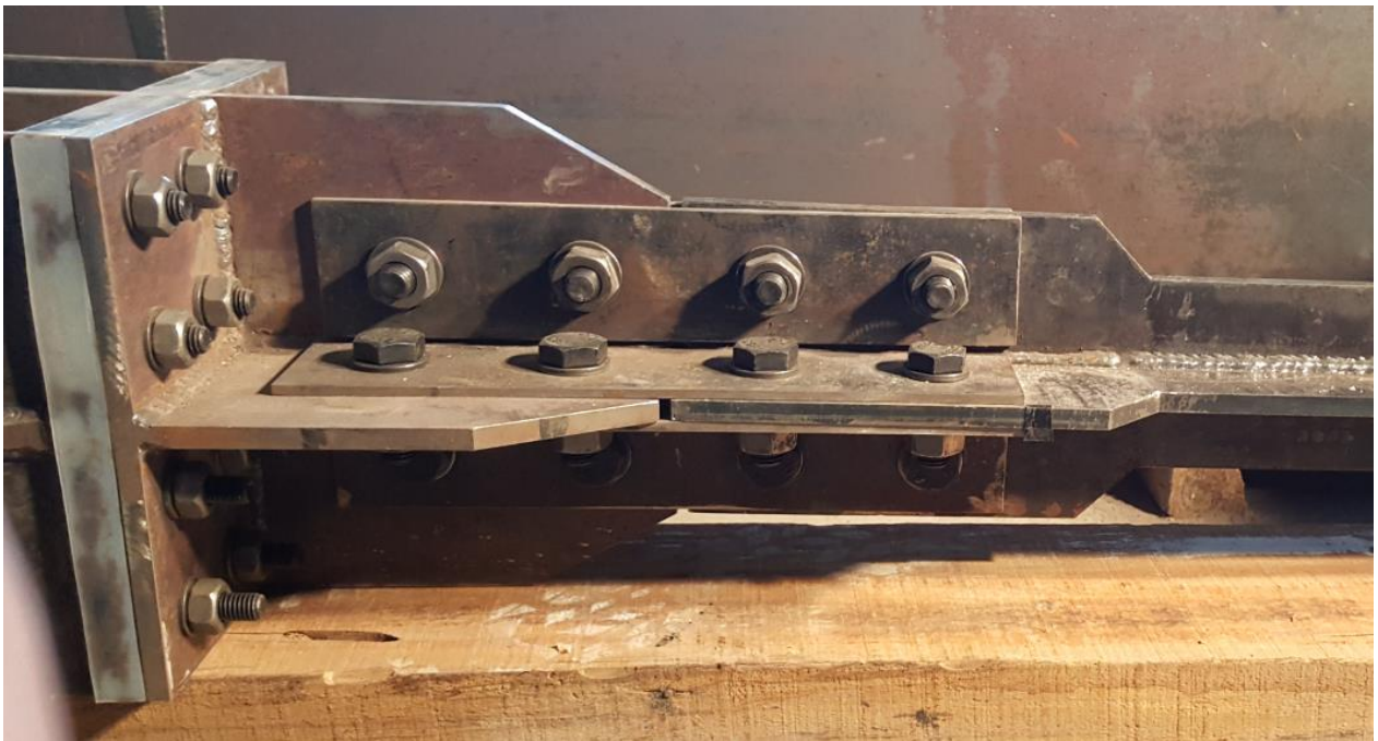
Figura 2.14: Conexión placa Gusset con extremo del BRB.
