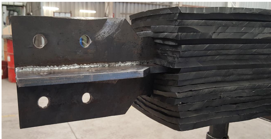
Figura 4.10: Relleno con planchas de elastómero zona extrema.
