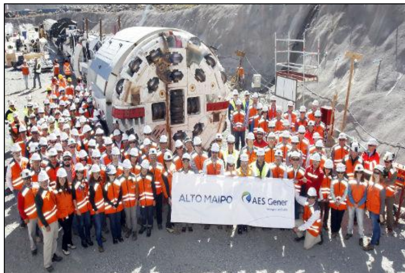
Figura 4.5 TBM Proyecto Alto Maipo.
