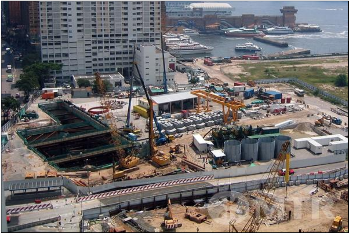
Figura 7.14 Instalación de faena típica dentro de una zona urbana.
