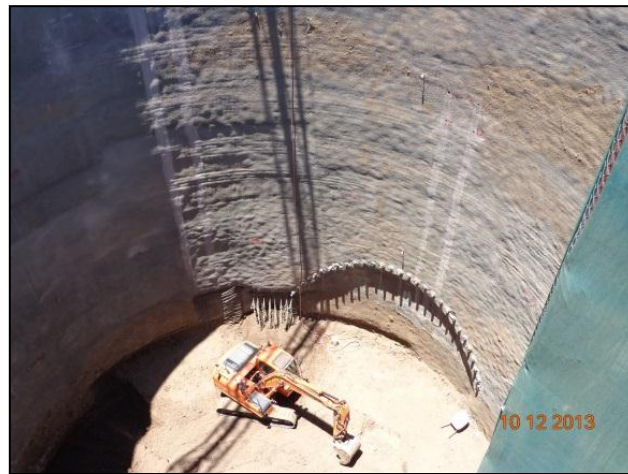
Figura 2.4 Pique de construcción Granada, Línea 3.
