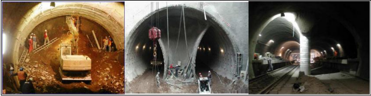
Figura 1.4 Estación construida mediante método NATM.
