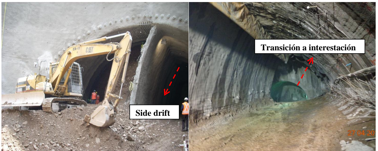
Figura 8.1 Transición entre túnel estación e interestación
