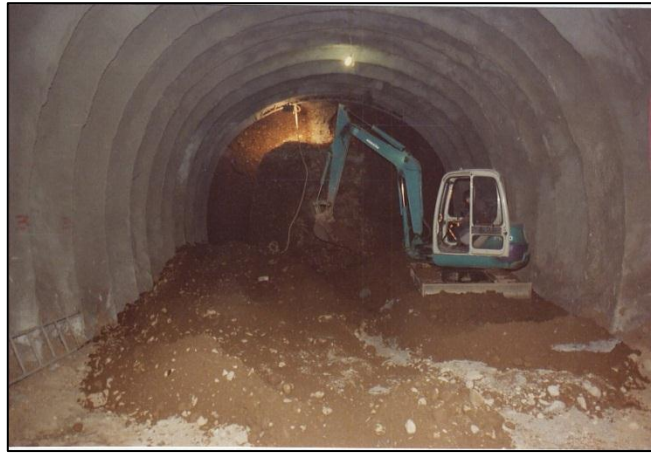
Figura 1.2 Primer túnel construido con método NATM, Línea 5.
