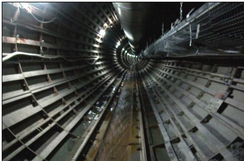
Figura 4.4 Interior Túnel Sur, sostenimiento con dovelas metálicas.
