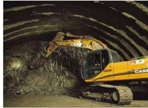
Figura 7.10 Excavación de túnel por medios mecánicos.
