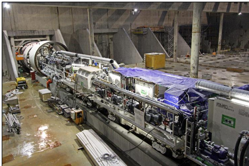
Figura 3.9 Sistema Back Up de un escudo Herrenknecht.
