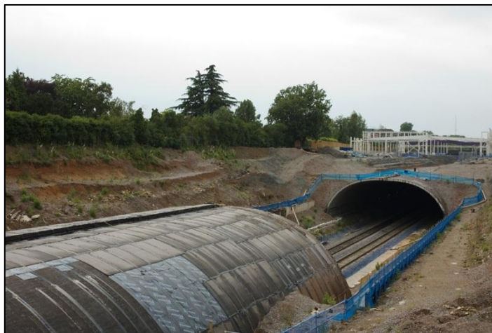
Figura 2.1 Túnel construido mediante método Cut and Cover.
