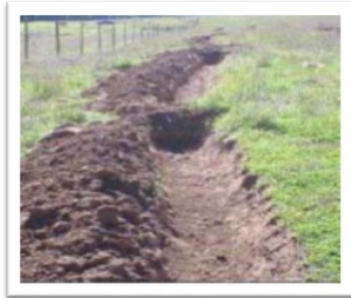
Figura A.4 Fotografía de una zanja de infiltración en Hidalgo (Chile) perteneciente al proyecto de investigación EIAS para la “Determinación de estándares de ingeniería en obras de conservación y aprovechamiento de aguas y suelos para la conservación e incremento de la productividad silvícola” (2005).
