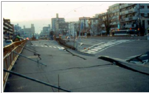
(a) Asentamiento de subsuelos sobre el túnel.
