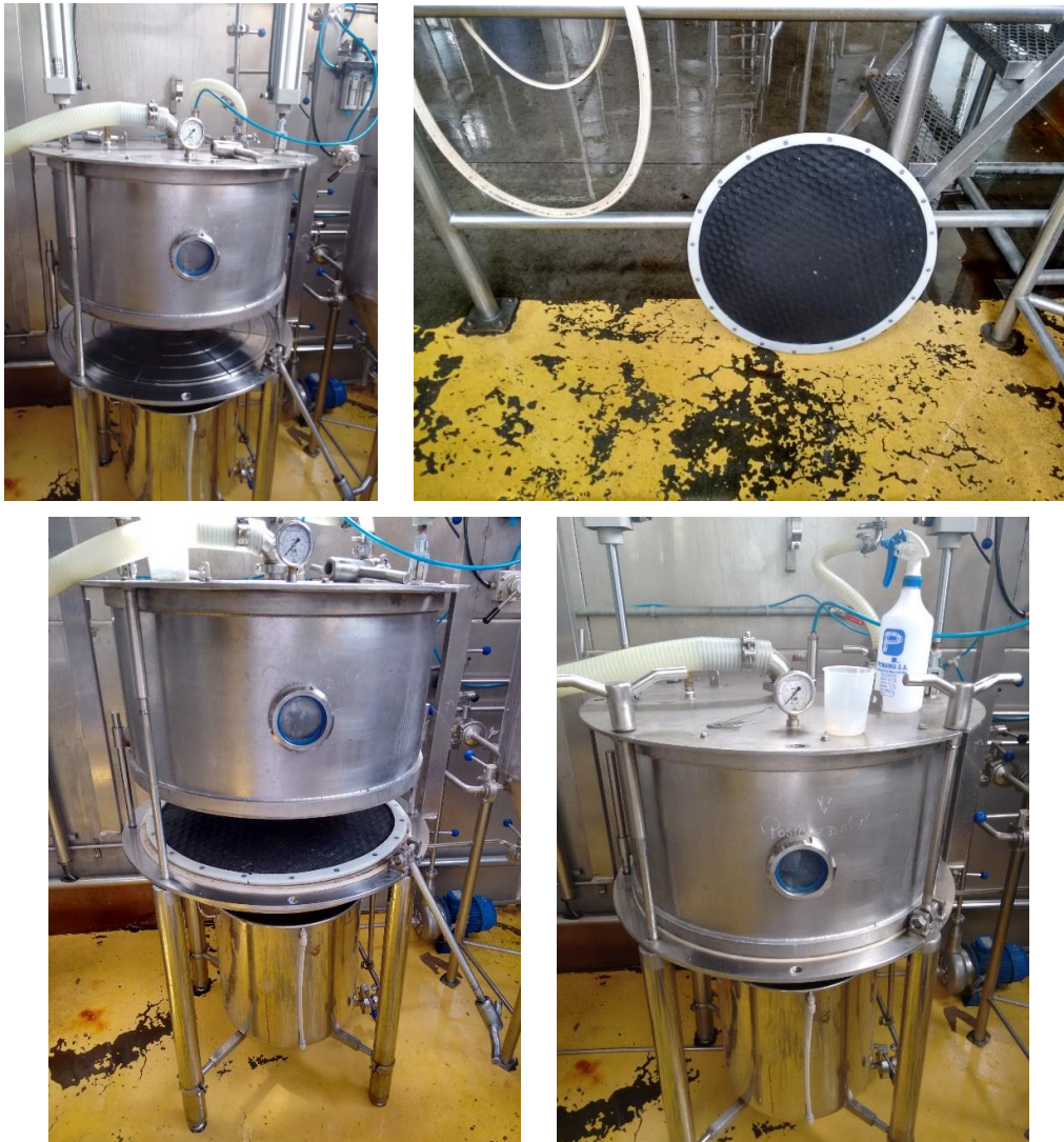
Figura 7: Instalación de la malla en el filtro vertical. En la primera imagen, filtro sin malla. Segunda imagen, la malla del filtro y la goma de soporte. Tercera imagen, posicionamiento de la goma de soporte abajo la malla del filtro. Cuarta imagen, filtro cerrado.
