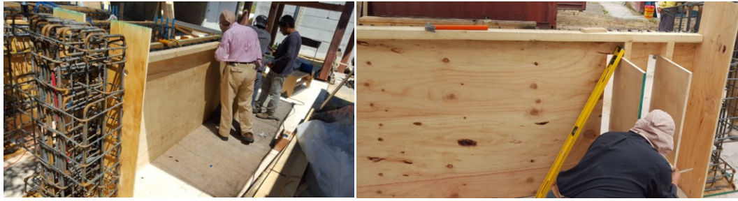
Figura 0.11: instalación moldajes.
