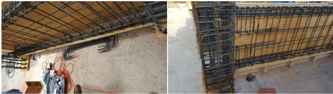
Figura 0.9: Armaduras en terreno.
