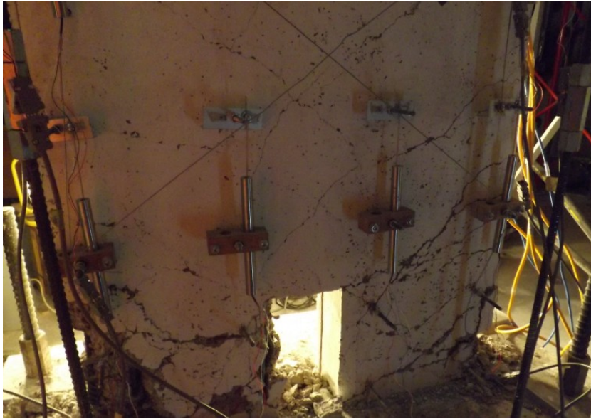
Figura 0.26: Grietas estado final MR1.
