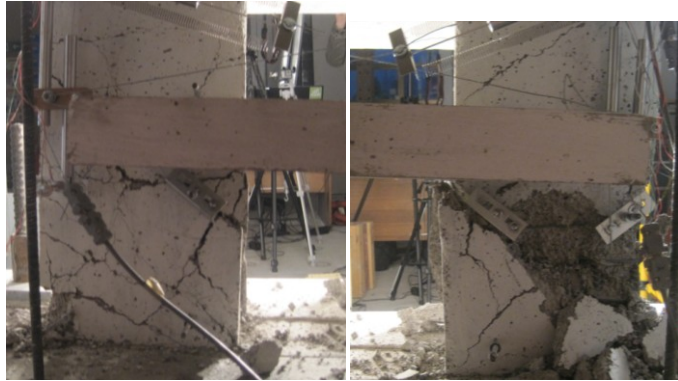
Figura 0.39: Grietas bajo la losa inferior una vez finalizado el ensayo.
