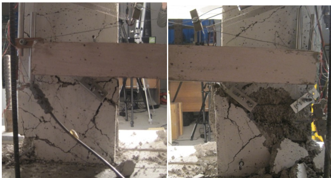
0.37: Estado probeta MR4 en la falla.
