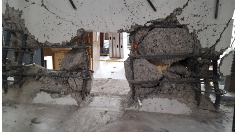
Figura 0.23: Armaduras, proceso de demolición MR1.
