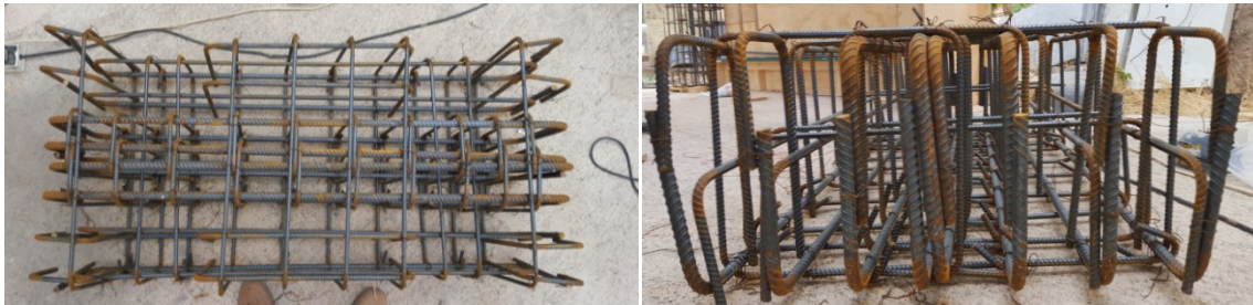
Figura 0.8: Armadura fundación.
