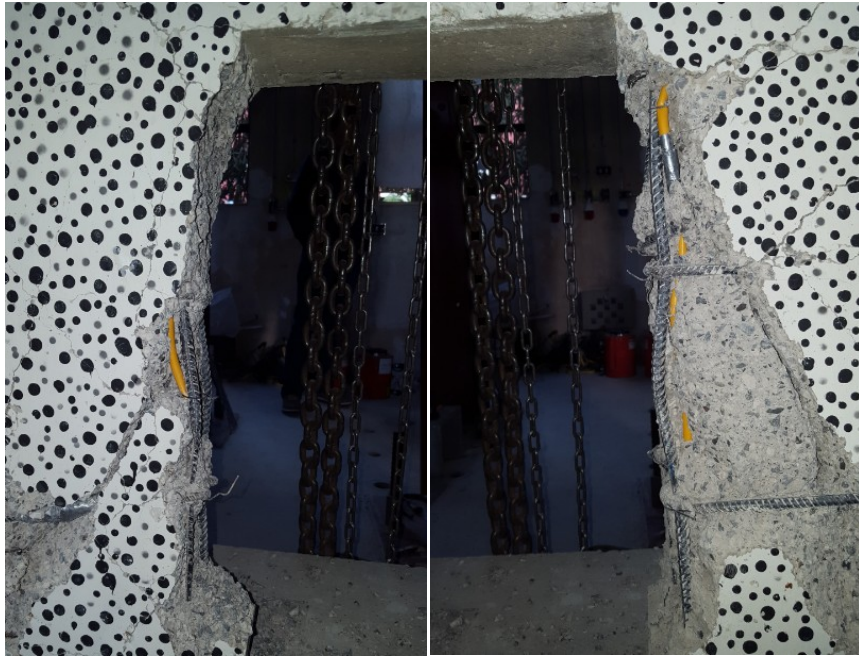
Figura 0.33: Pandeos en armaduras de la abertura MR3.
