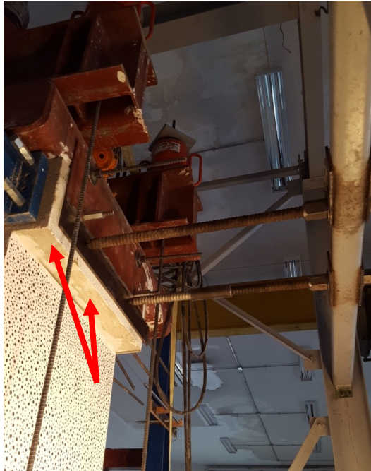
Figura 3.16: Puntales para restricción de desplazamientos fuera del plano.
