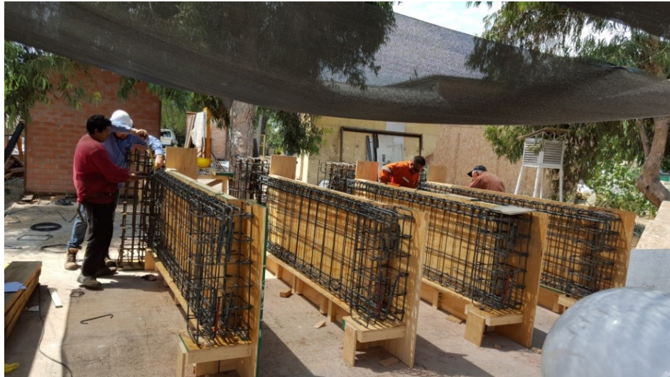
Figura 3.3: Armadura muros en terreno.
