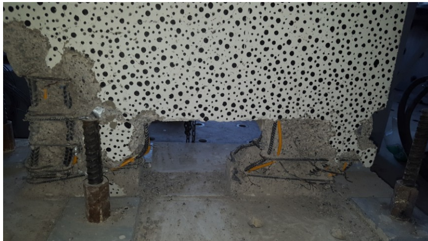
Figura 0.30: Estado probeta MR2 en la falla (2).
