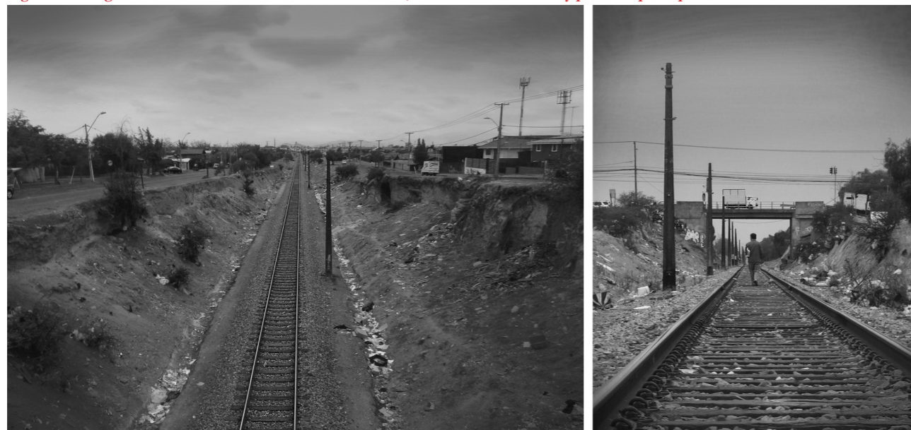
Figura 27: Fotografías de la vía férrea en situación de trinchera, acumulación de basura y precarios pasos peatonales.
