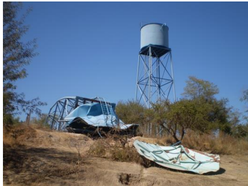
Figura 5. Copa de agua destruida por efecto del terremoto en la comunidad de El Manzano, comuna de Las Cabras
