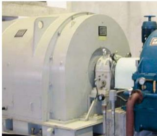
Cliente: LAGINHA AGRO INDUSTRIAL Pais: Brasil Suministro: 6.250 kVA, 13.800 V, 4 pólos Aplicación: Turbina a vapor (Usina de açúcar e álcool) Combustible: Biomassa
