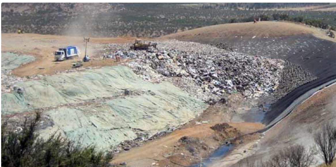
Figura 12: Frente de trabajo relleno sanitario. Fuente [17].
