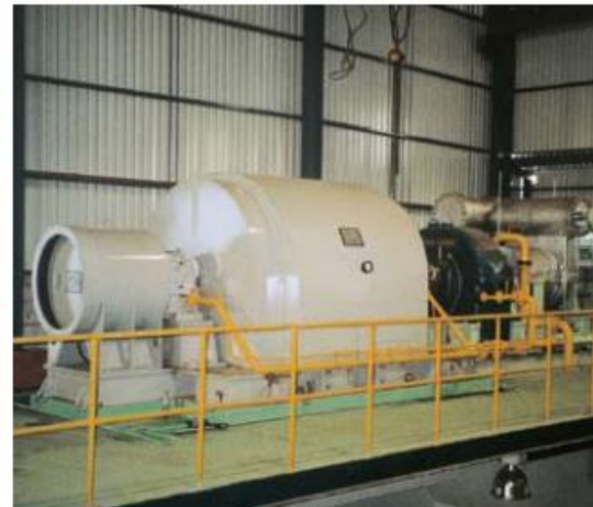
Cliente: UNI-SYSTEMS Cliente final: Engenho Monte Rosa Pais: Nicaragua Suministro: 18.750 kVA, 13.800 V, 4 polos Aplicación: Turbina a vapor (Usina de açúcar y alcohol) Combustible: Bagazo de caña Año de fabricación: 2001
