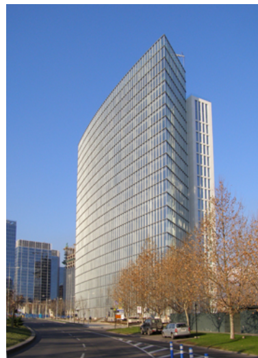
Figura 1.19: Edificio Parque Araucano
