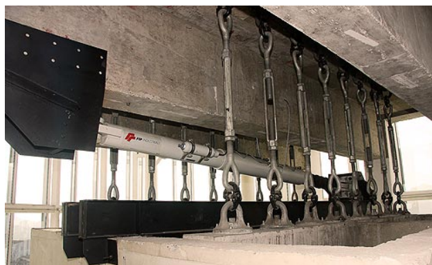
Figura 1.29: Incorporación amortiguador viscoso, AMS Parque Araucano
