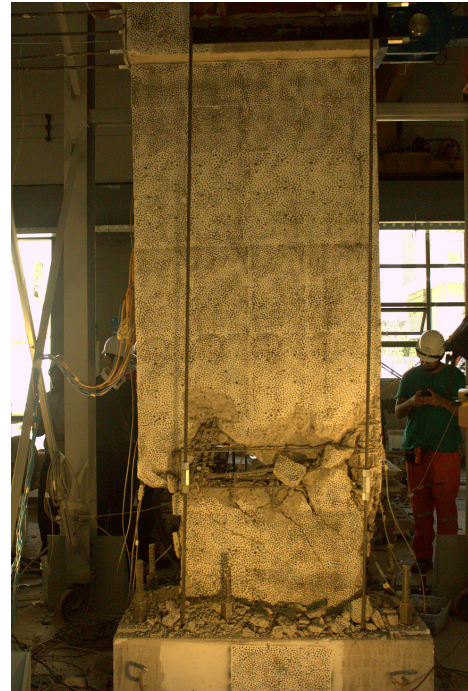
(b) Muro 4 al final del ensayo.
