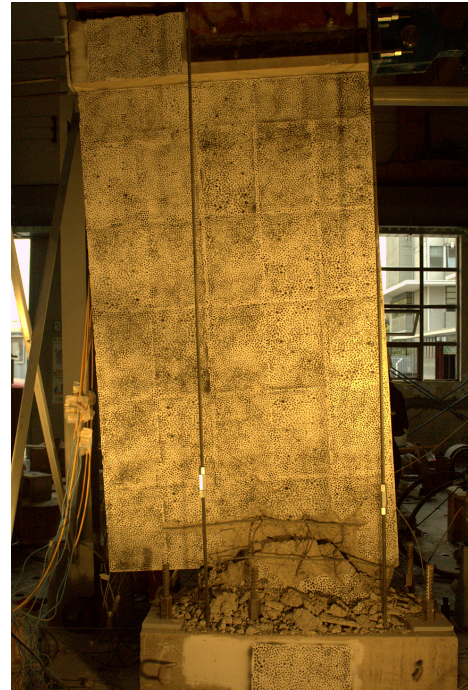
(b) Muro 3 al final del ensayo.
