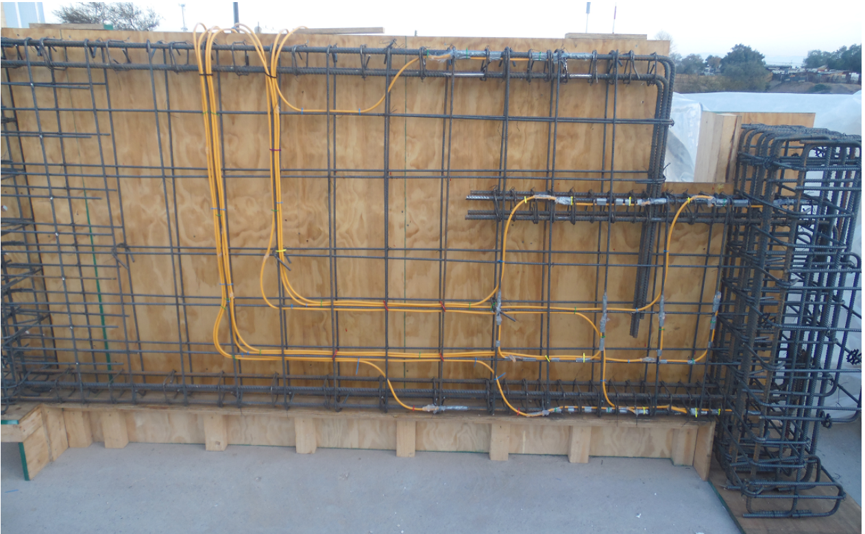
Figura 3.4.12: Instalación final Strain Gages.
