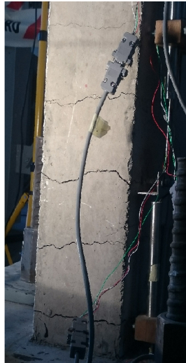
(a) Daño al 2 % en zona traccionada para carga lateral negativa.
