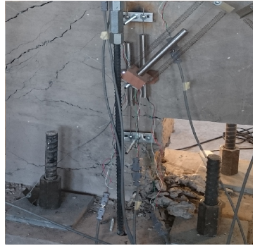
Figura 4.3.10: Agrietamiento Muro 3, lado discontinuo.
