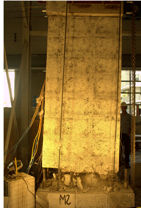
(b) Muro 2 al final del ensayo.
