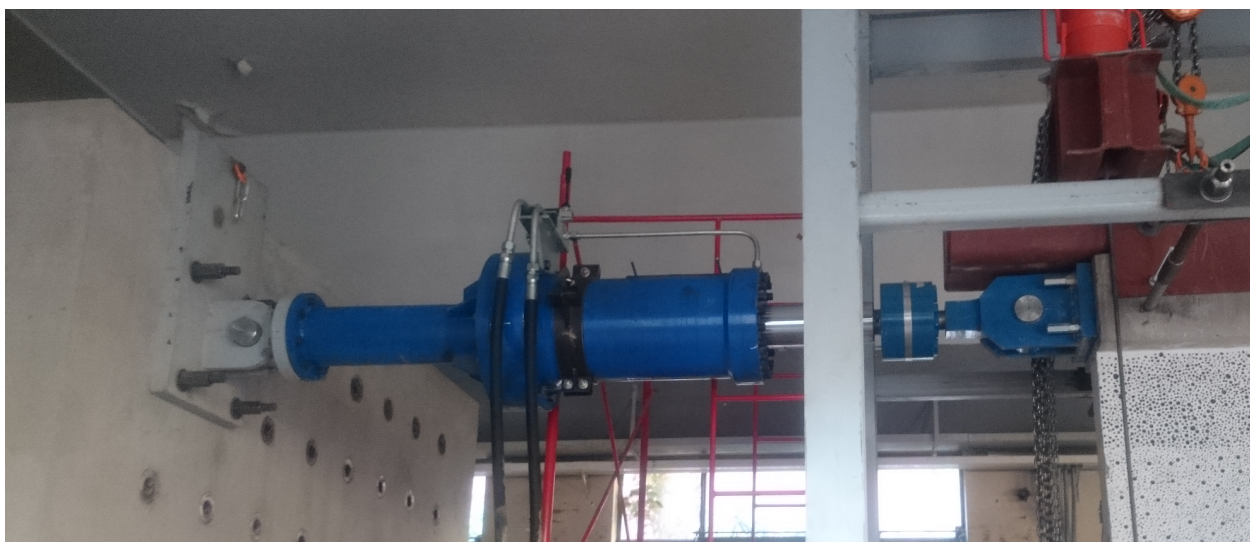
Figura 3.5.17: Montaje del Sistema de Carga Lateral.
