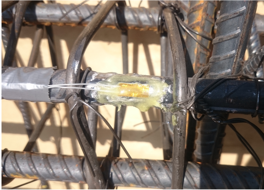
Figura 3.4.10: Instalación de un Strain Gages.
