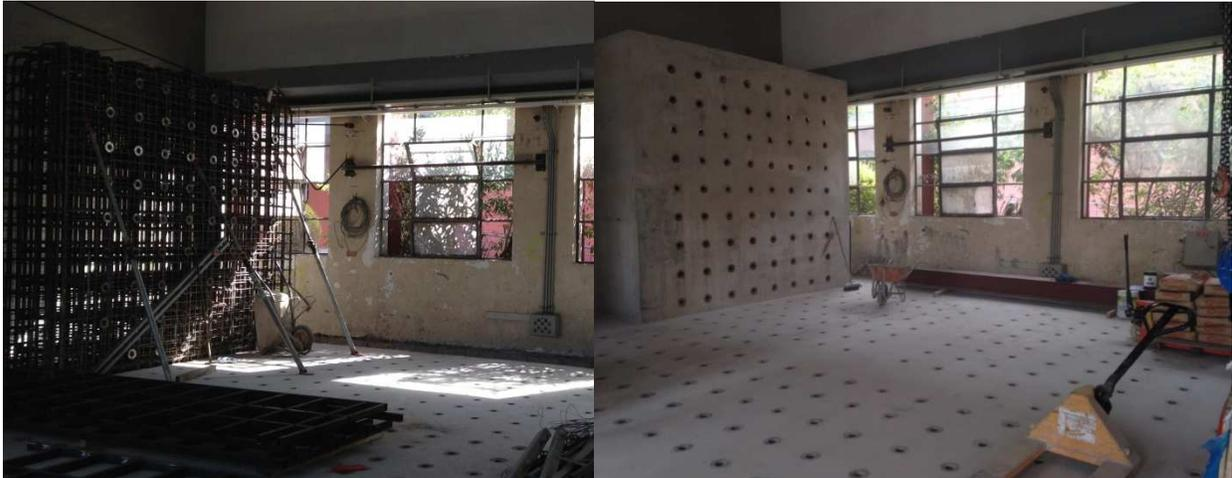
Figura 18: Espacio del laboratorio donde se realizan los ensayos, antes y después de la construcción del muro de reacción.
