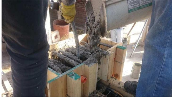
Figura 31: Momento en que se vierte y se vibra el hormigón en el moldaje.
