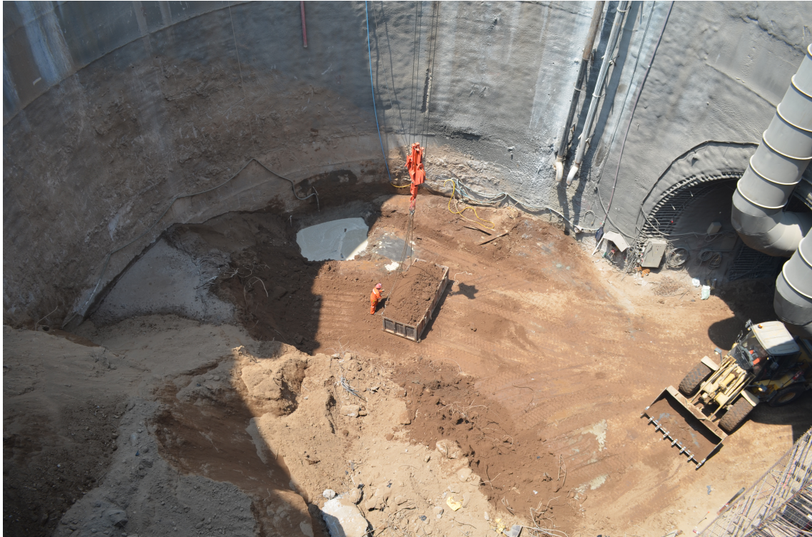
Figura 14: Retiro de marina Pique construcción L3 del Metro de Santiago
