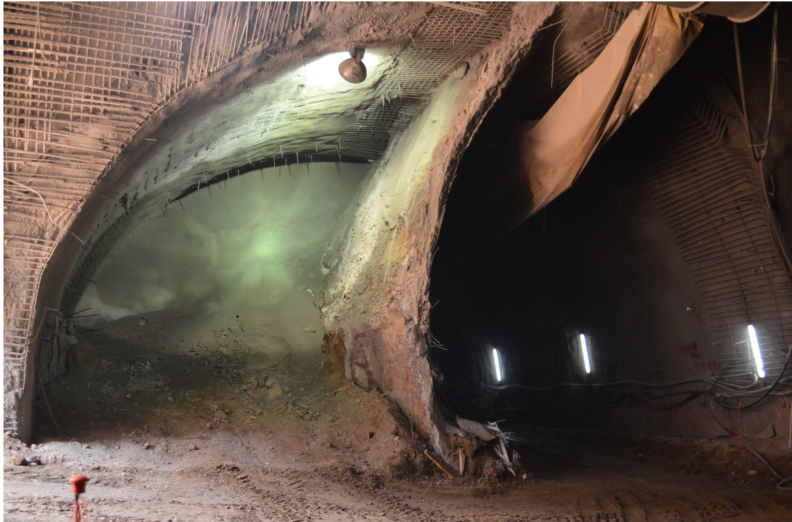
Figura 12: Ejemplo Side Drift en Túnel Estación en construcción L3 del Metro de Santiago
