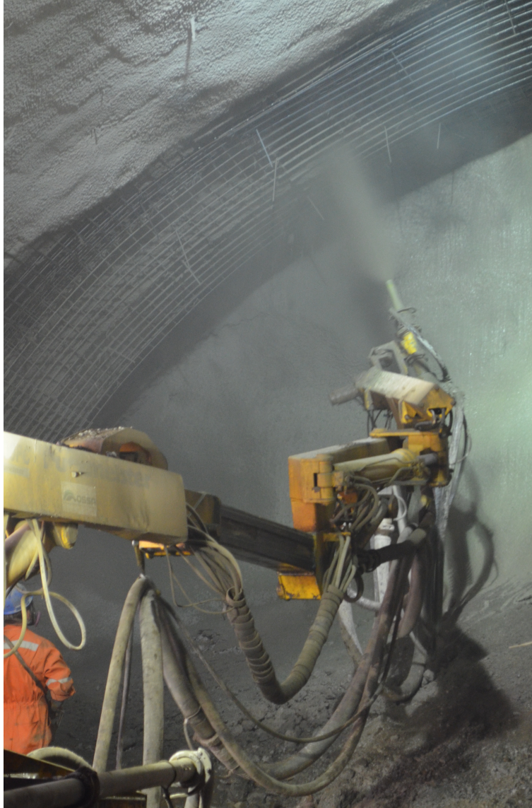
Figura 10: Proyección de Shotcrete mediante brazo robotizado
