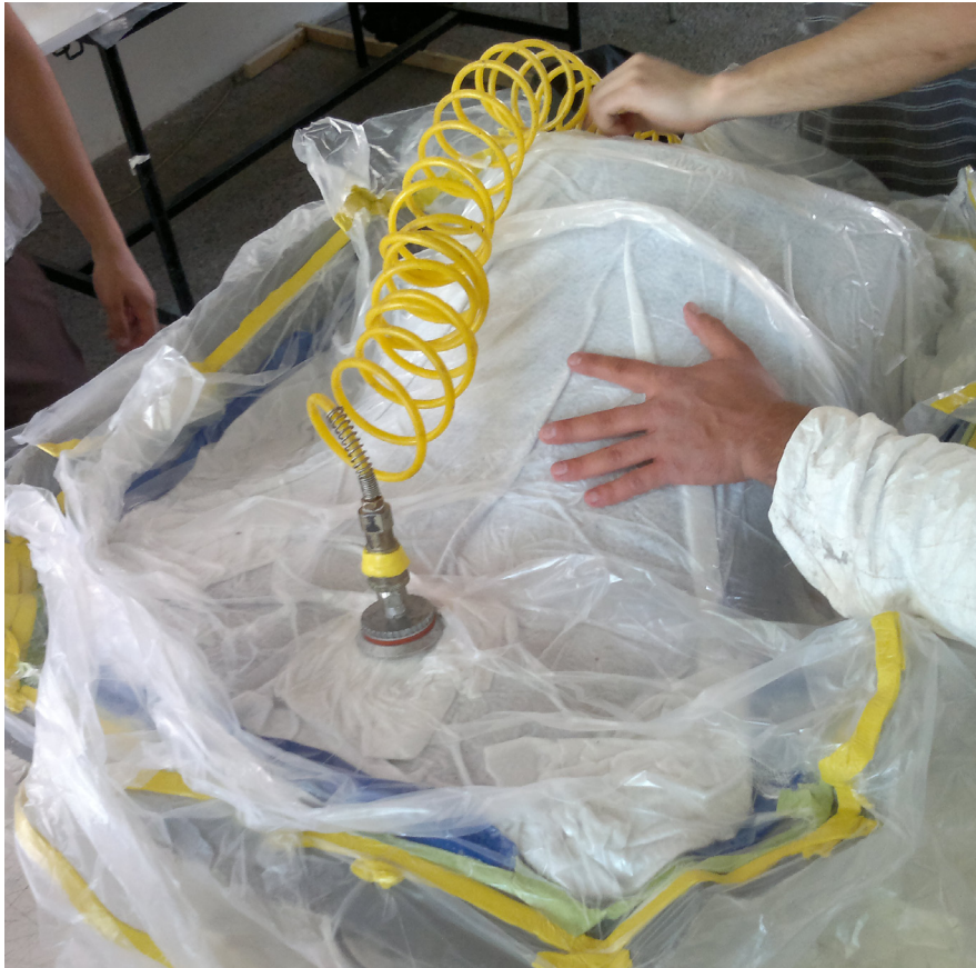
Fotografía de laminado al vacío. Fuente: fotografía del autor
