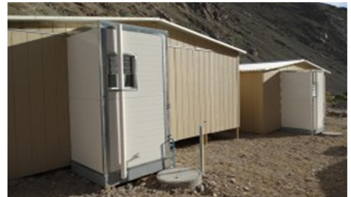
Imagen 12: Foto vivienda con baño modular conectado a red de alcantarillado provisoria. Fuente: http://atacamaenlinea.cl/?p=16338
