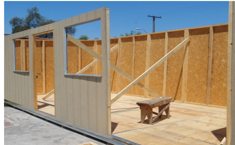
Imagen 8: Interior vivienda básica en construcción. Fuente: http://www.plataformaarquitectura.cl/cl/02-361062/en-detalle-vivienda-basica-chile
