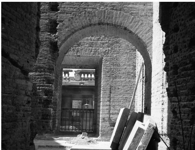
Fig. 111 Fotografía arco al interior del muro. Fuente: AFDA
