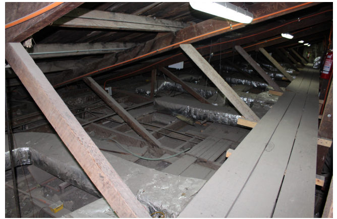
Fig. 151 Estructura de cubierta Edificio ex Congreso Nacional sector poniente. Elaboración propia
