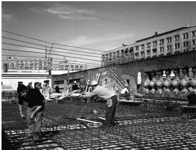
Fig. 114 Sectores con hormigón armado en Palacio de la Moneda. Fuente: AFDA
