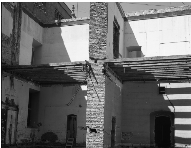
Fig. 104 Entrepiso y muros de albañilería Palacio de La Moneda. Fuente: AFDA
