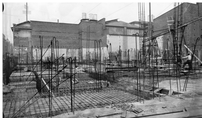
Fig. 217 Fotografía ejecución de losas Palacio de Tribunales. Fuente: AFDA
