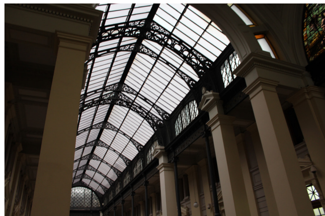
Fig. 235 Fotografía armadura metálica Sala Pas Perdus. Elaboración propia
