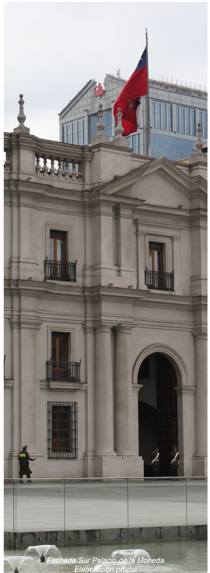
Fig. 92 Fotografía Palacio de la Moneda terminaciones arena y cemento. Fuente AFDA
