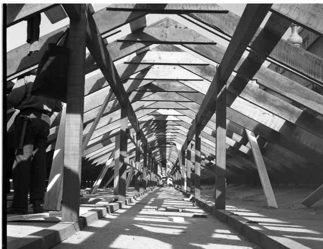
Fig. 89 Estructura de cubierta del Palacio de la Moneda. Fuente: AFDA
