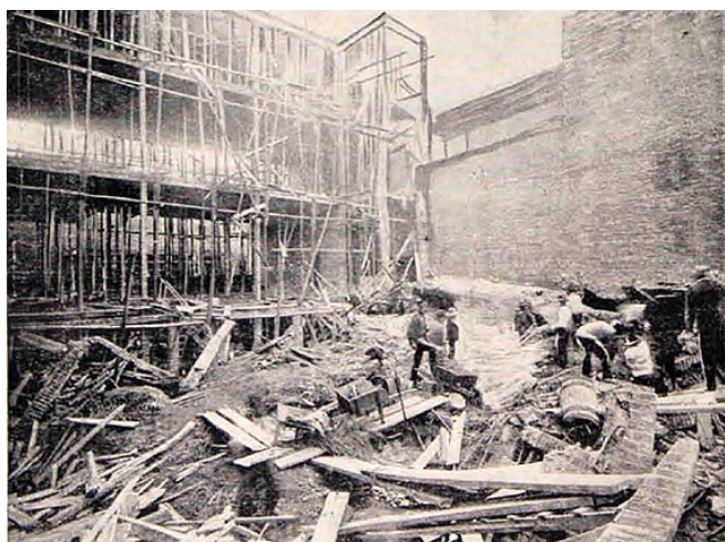
Fig. 54 Fotografía Casa Prá (1904). Primeros usos del hormigón armado. Fuente: Urbatorium
