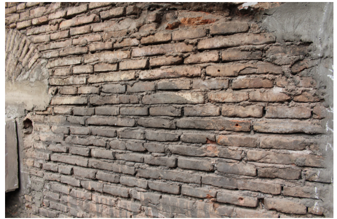
Fig. 144 Aparejo ladrillos en entretecho. Elaboración propia
