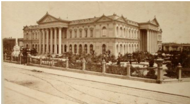
Fig. 122 Vista Edificio Ex Congreso Nacional. Fuente: Memoria Chilena
