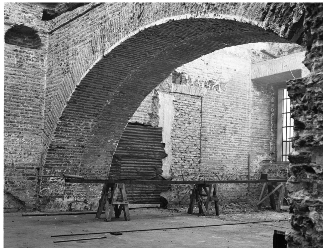
Fig. 112 Fotografía arco elíptico sur poniente Palacio de La Moneda. Fuente: AFDA
