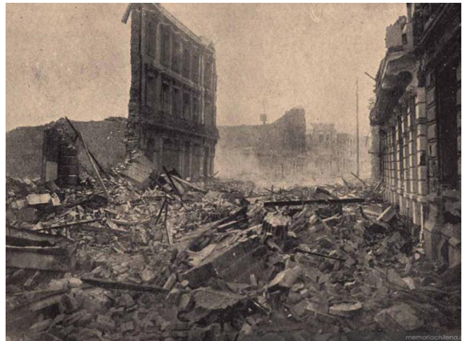
Fig. 49 Valparaíso tras terremoto 1906. Fuente: Memoria Chilena.
