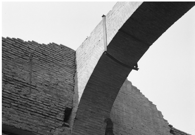
Fig. 113 Fotografías arco de contraste. Fuente: AFDA
