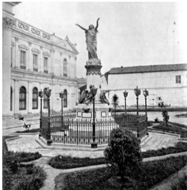
Fig. 136 Monumento a las víctimas incendio de la Compañía. Fuente: Archivo DEPA MOP
