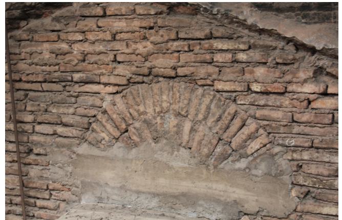
Fig. 145 Arco de descarga al interior del paramento sector entretecho. Elaboración propia
