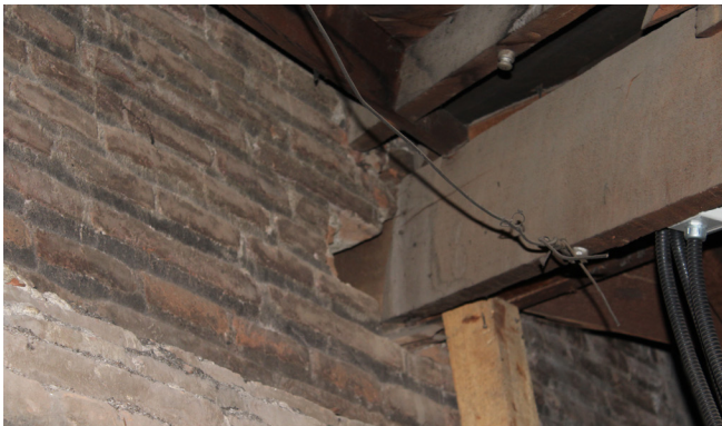
Fig. 170 Fotografía encuentro muro y estructura de cubierta. Elaboración propia
