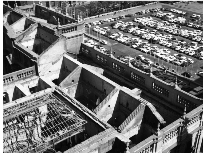
Fig. 77b Tímpanos entre estructura de cubierta Palacio de la Moneda. Fuente: ADFA
