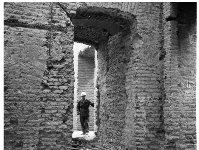
Fig. 101 Muros de Albañilería Palacio de La Moneda. Fuente: AFDA
