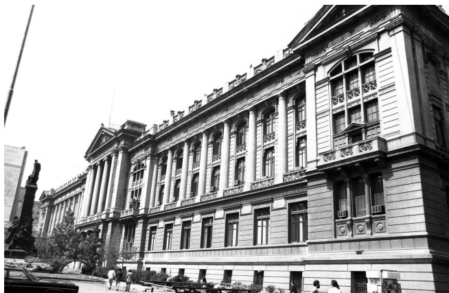
Fig. 185 Fotografía fachada Palacio de Tribunales. Fuente: AFDA
