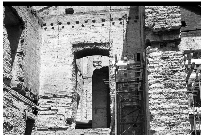
Fig. 106 Fotografía perforaciones envigado de cielo Palacio de La Moneda. Fuente: AFDA
