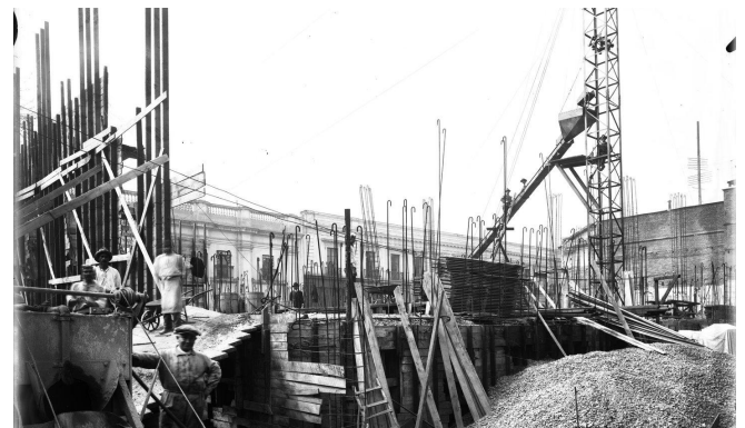
Fig. 239 Enfierraduras en la obra de la segunda etapa del Palacio de Tribunales. Fuente: AFDA
