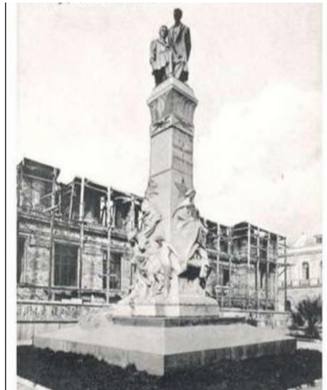
Fig. 198 Fotografía Monumento Montt Varas. Fuente: Archivo DEPA MOP
