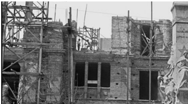
Fig. 229 Fotografía histórica construcción fachada norte. Fuente: Archivo DEPA MOP
