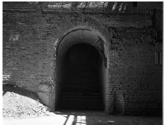
Fig. 108 Fotografía bóvedas Palacio La Moneda. Fuente: AFDA
