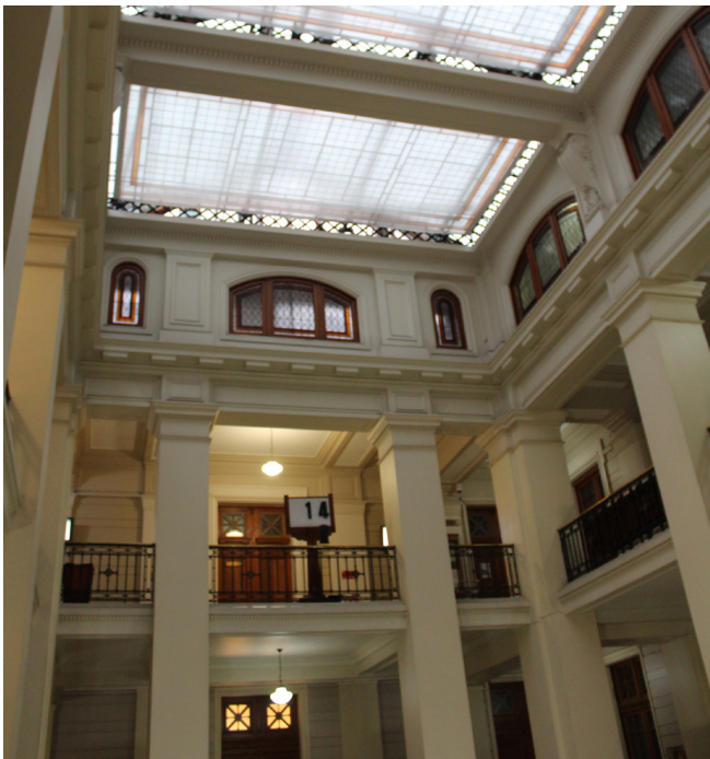
Fig. 189 Fotografía patio interior. Elaboración propia
