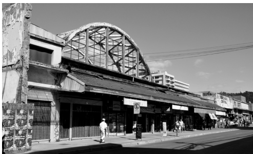
Imagen 36: Fachada trasera Mercado 2016 / Fuente: Elaboración propia
