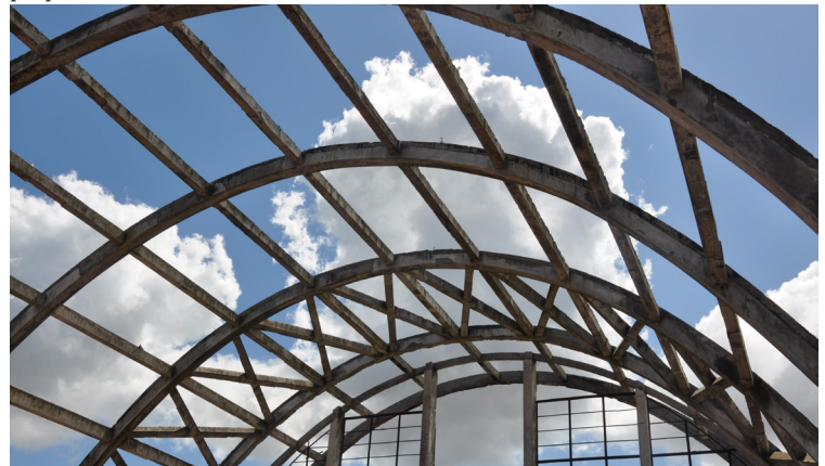
Imagen 21: Cielo Interior Bóveda 2016/ Fuente: Elaboración propia
