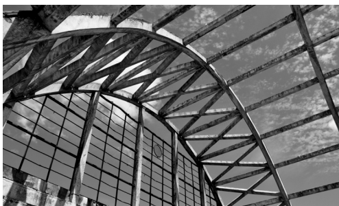
Imagen 34: Interior Mercado 2016 / Fuente: Elaboración propia
