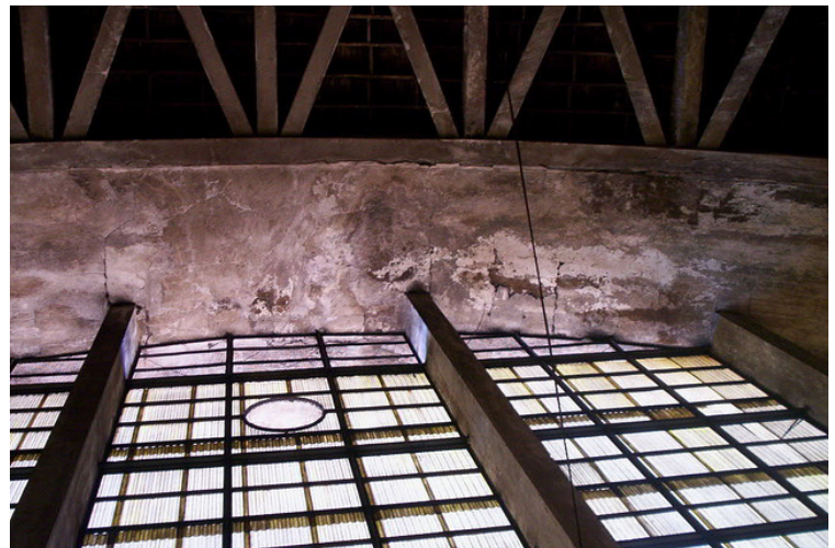
Imagen 19: Cielo Interior Fachada 2013 / Fuente: Daniela Tapia
