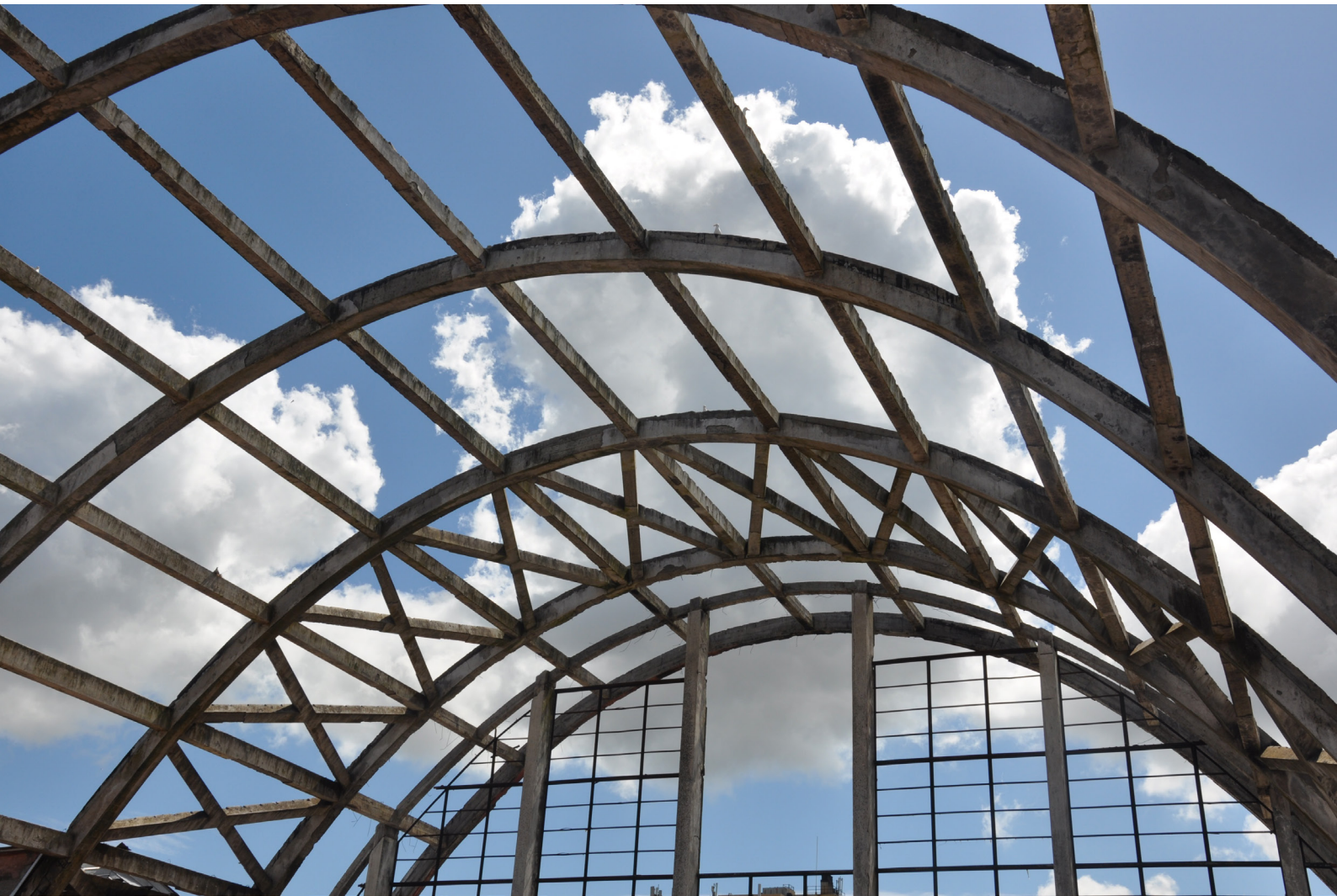
Imagen 1: Estructura nave central 2016/ Fuente: Elaboración propia
