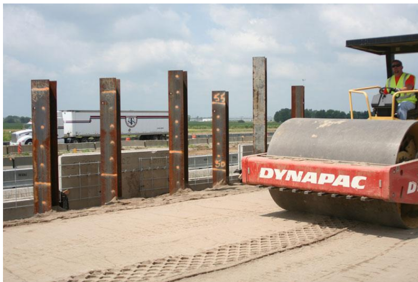
Figura 2.25 Compactación pesada realizada en muros mecánicamente estabilizados.
