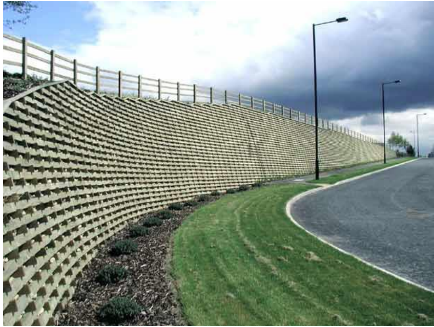
Figura 2.4 Ejemplo Muro Crib-Bin, Jara (2010).
