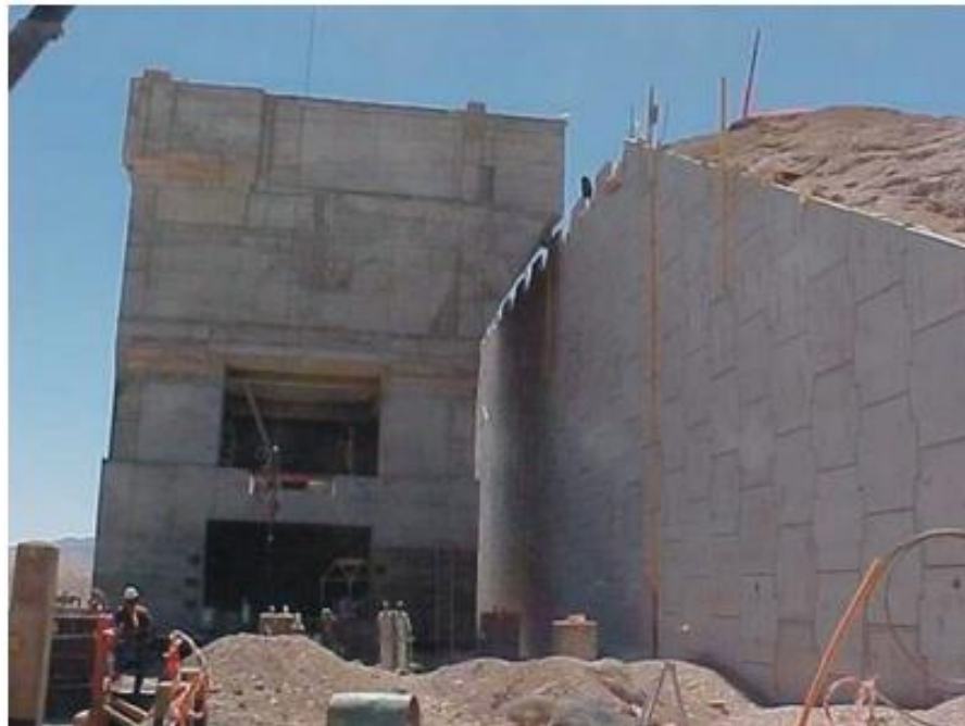
Figura 2.6 Muro chancador El Tesoro, Calama, Chile. Tierra Reforzada.
