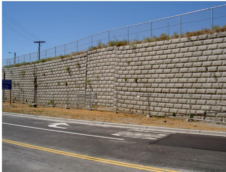
Figura 2.15 Dislocación de la fachada, Schmidt et al. (2011).
