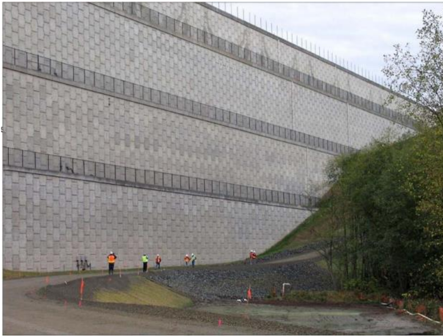
Figura 2.5 Carretera Aeropuerto Seattle. 46 m de altura, Tierra Armada.
