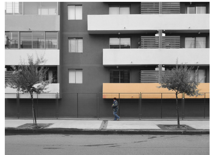
Imagen 30. Cerramiento con estacionamientos.
